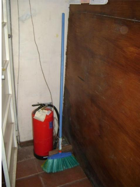
Foto # 9: Extintores ubicados en lugares inadecuados, los extintores no son de libre acceso, los extintores se encuentran descargados (Almacén)
