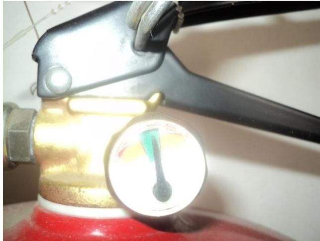
Foto # 7: Los extintores se encuentran descargados (Pasillos)
