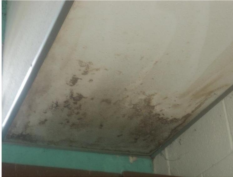
Foto # 15: Cielo falso en mal estado, Humedad en techos y paredes
