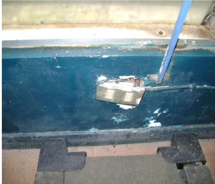
Foto # 25: Tomacorrientes en mal estado (Mecanoterapia)
