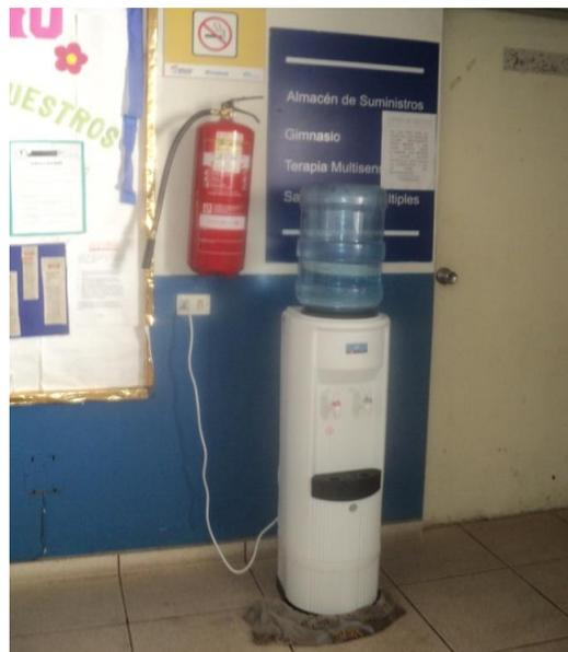
Foto # 8: Ubicación inadecuada de extintores, Falta de señalización de los extintores (Pasillos)
