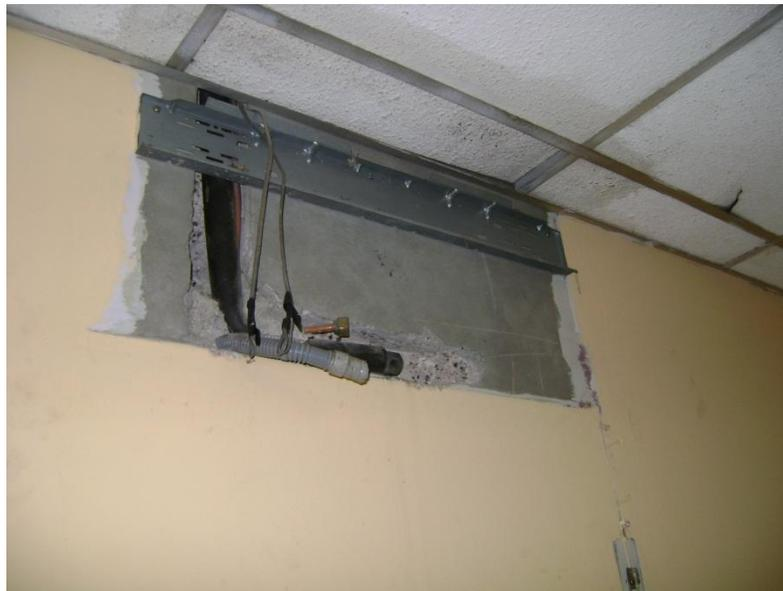
Foto # 14: Humedad en techos y paredes, Falta de ventilación adecuada (Dirección)
