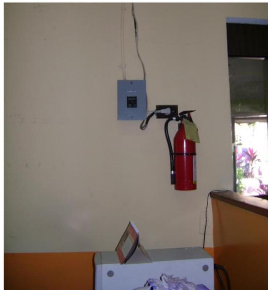
Foto # 10: Extintor ubicado en forma inadecuada, Falta de señalización de los extintores, Los extintores no son de libre acceso (Atención al usuario)
