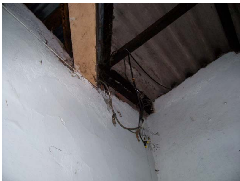
FOTO 31: PAREDES DE ADOBE, AREA DE LAVANDERIA.
