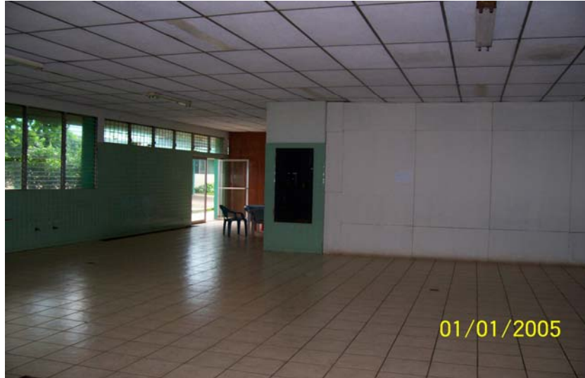
FOTO 60: PARED DE PLYWOOD QUE DIVIDE COCINA DE ALMACEN.
