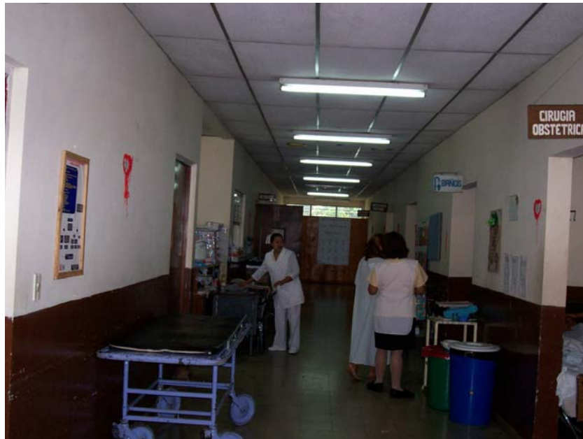
FOTO 52: AMPLIO PASILLO DEL ÁREA DE EMERGENCIA
