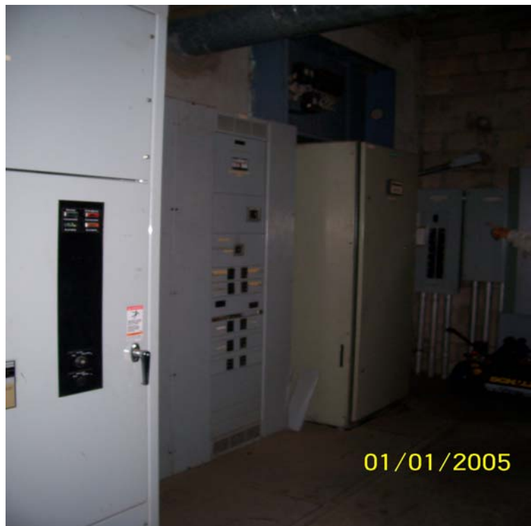
FOTO 78: ÁREA DE TRANSFERENCIA EN SONSONATE.
