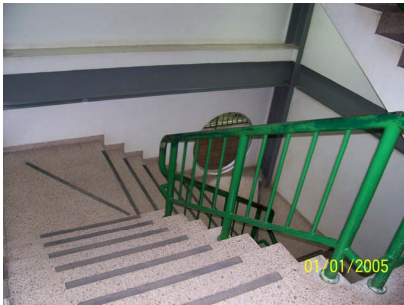
FOTO 72. SISTEMA ESTRUCTURAL PRINCIPAL DE ACERO EN EL EDIFICIO CRITICO.
