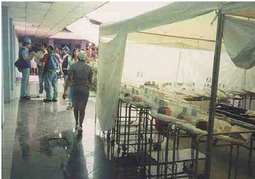
FOTO 2. DAÑOS A HOSPITAL 1° DE MAYO, ISSS A RAZ DEL TERREMOTO DEL 13 DE ENERO DEL 2001
