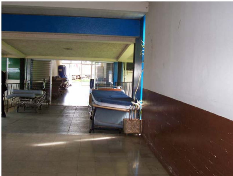
FOTO 42: PARTE DEL SISTEMA ESTRUCTURAL DEL TECHO HECHO DE LOSA DE CONCRETO
