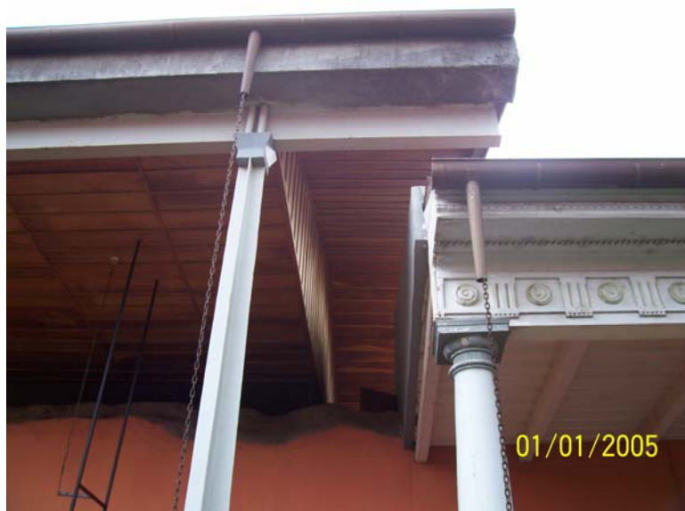
FOTO 70; EDIFICIO COLONIAL, SISTEMA ESTRUCTURAL DEL TECHO DE MADERA, COLUMNAS DE MADERA.
