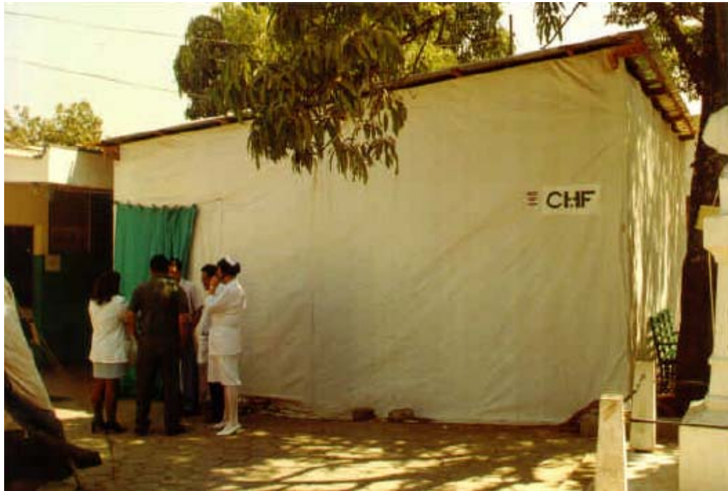
FOTO 9. HOSPITAL NACIONAL SANTA GERTRUDIS. QUIRÓFANO TEMPORAL
