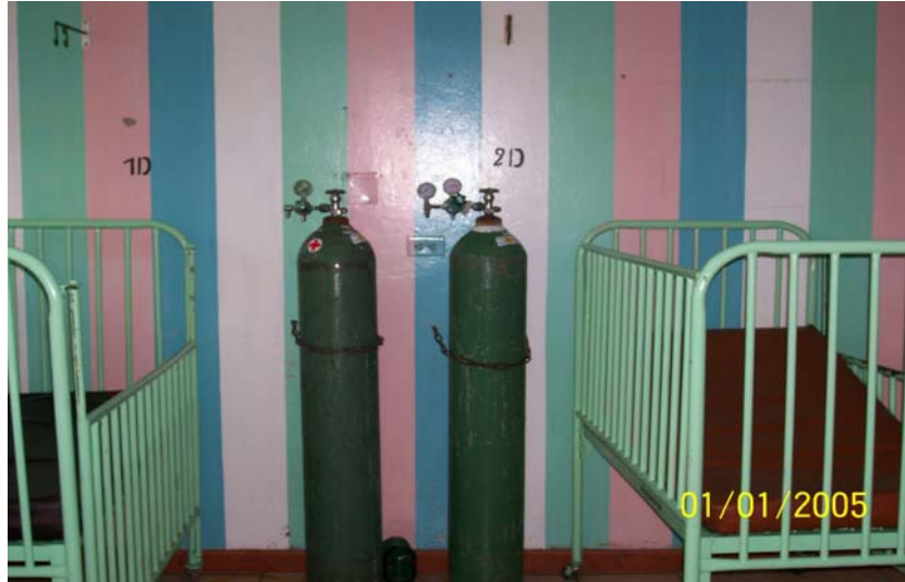
FOTO 64: TANQUES DE OXIGENO ASEGURADOS EN EL ÁREA DE PEDIATRIA.
