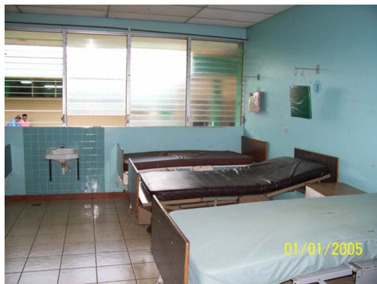
FOTO 55: PAREDES DE LADRILLO CON CUBIERTA DE CEMENTO
