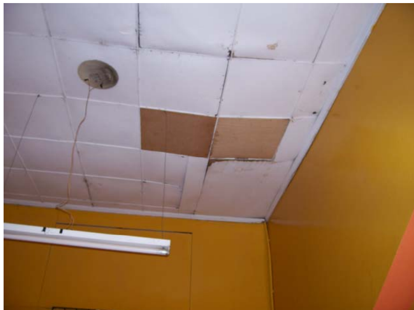
FOTO 30: LÁMPARAS SIN PROTECCIÓN, PAREDES DE ADOBE
