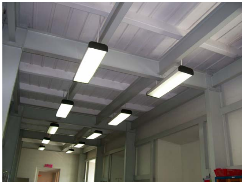
FOTO 74. REFORZAMIENTO CON COLUMNAS Y VIGAS DE ACERO EN EL EDIFICIO COLONIAL EN EL AREA DE ENCAMADOS.
