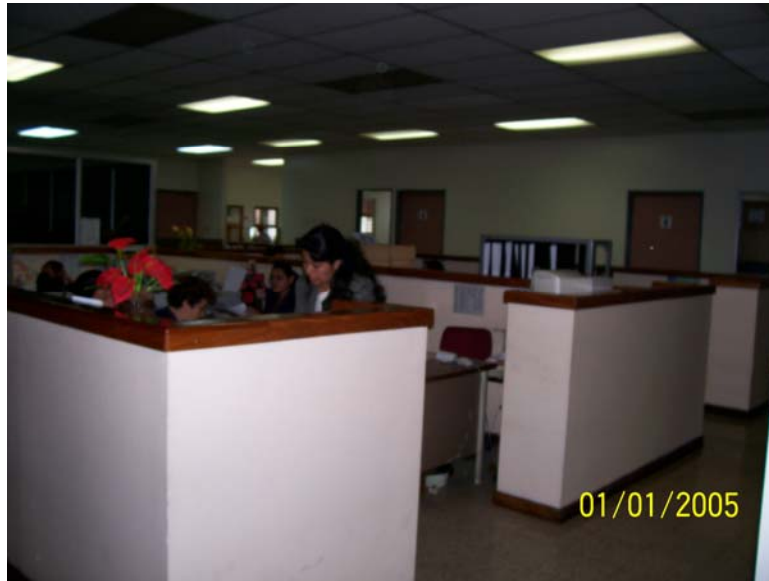
FOTO 69: EDIFICIO CRITICO: LAMPARAS CON PROTECCIÓN, DIVISIONES DE TABLA YESO.
