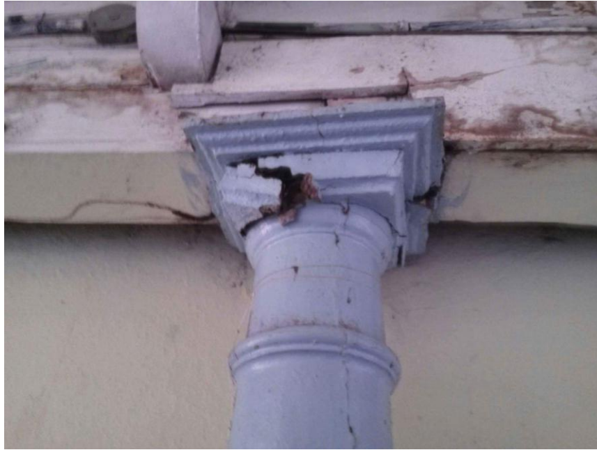
Imagen 1: Columna de madera de la unidad de consulta externa, área 4
