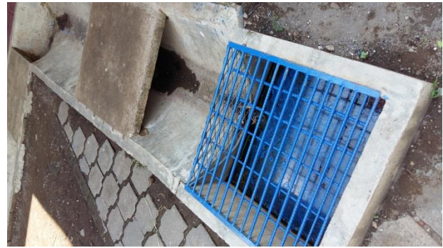
Canaletas desprotegidas que pueden ocasionar caídas de mismo nivel en las personas.
