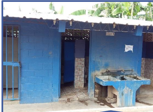
Entrada a servicios sanitarios
