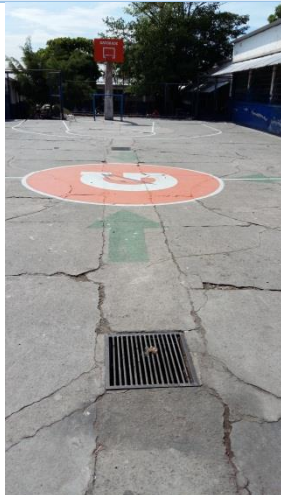
Área restringida dentro del centro escolar, debido a que fue declarada inhabitable por los severos daños en su infraestructura provocados por los terremotos del año 2001.
