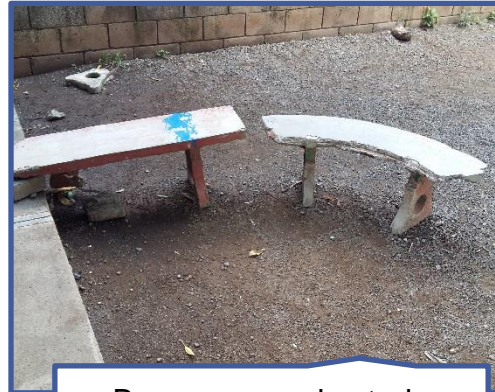
Bancas en mal estado
