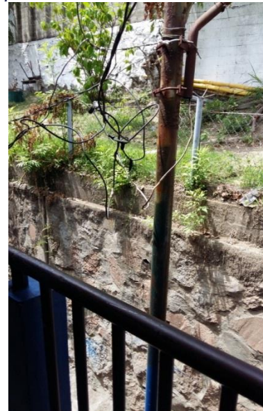
Ilustración 20. Riesgo eléctrico por cables sueltos en pabellón de bachillerato
