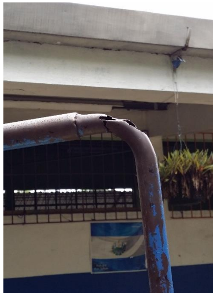
Ilustración 40: Pasamano con riesgo a cortadura debido a parte con filo.
