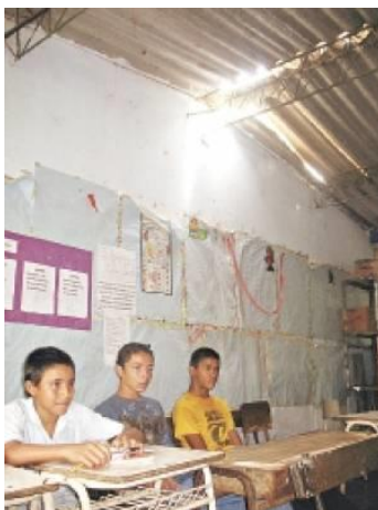
Ilustración 3: Centro Escolar de San Miguel con mala infraestructura.
