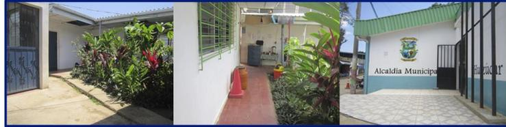
Figura 35. Fotografía del piso de concreto lanzado en circulaciones, piso de ladrillo terrazo en corredores y cerámica no antideslizante en acceso principal.
