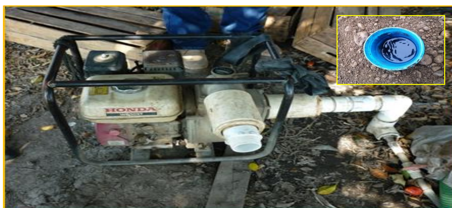
Imagen 3.3- 2: Pozo tipo puntera (4") y bomba achicadora diésel/gasolina, en uso actualmente.
