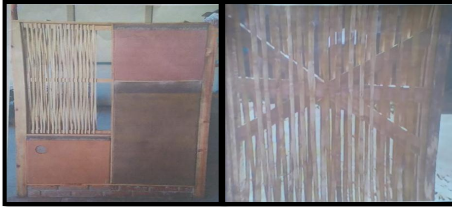
Figura: 27. Estructuras Prefabricadas de bambú.
