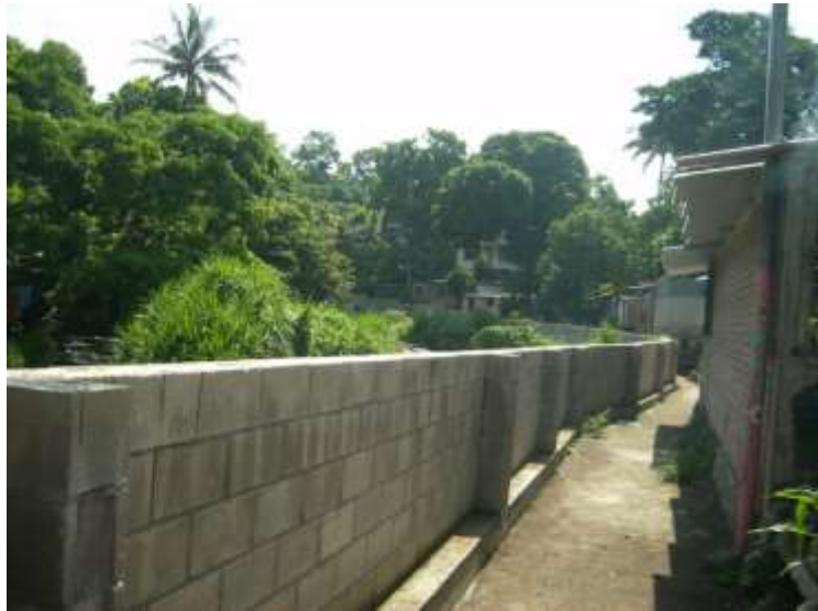
Figura 4. 4 Muro Pantalla Construido en la Comunidad Luces del Rio. Fuente: Propia.
