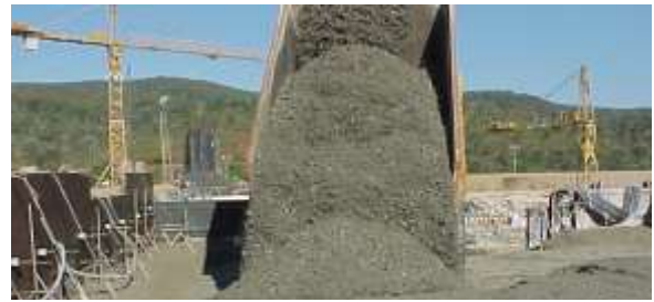
b) Vertido de CCR con camión de Volteo. Fuente: P.K. Mehta and Monteiro, 2013.
