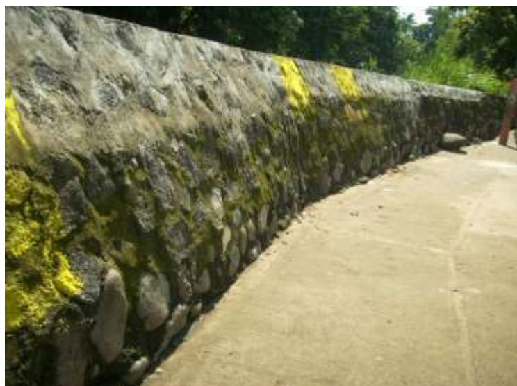
Figura 4. 5 Muro Construido en la comunidad El Palmar. Fuente: Propia.
