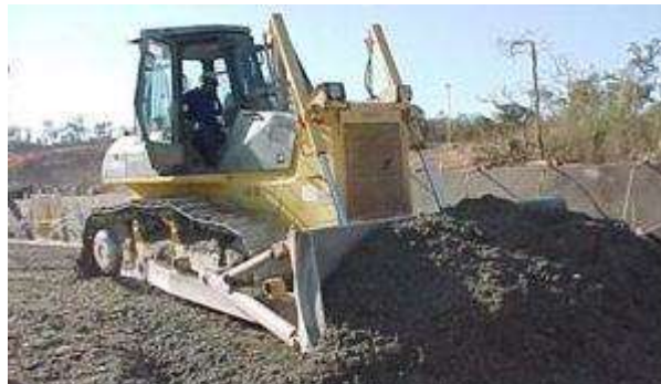
c) Distribución de CCR con Bulldozer. Fuente: P.K. Mehta and Monteiro, 2013.
