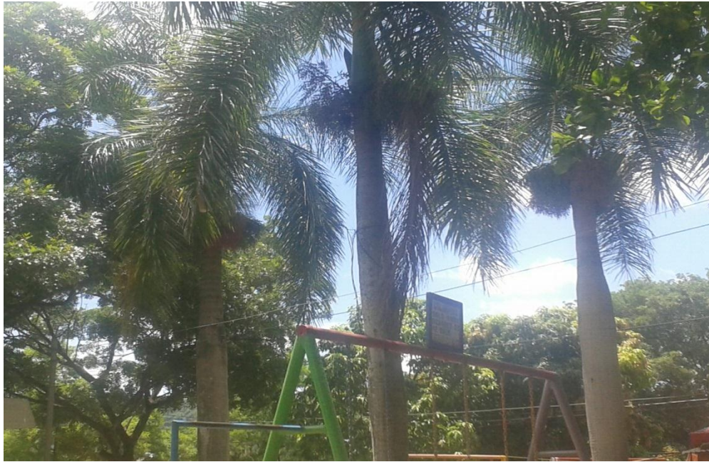
Figura 9. Cableado eléctrico instalado en condiciones inseguras.
