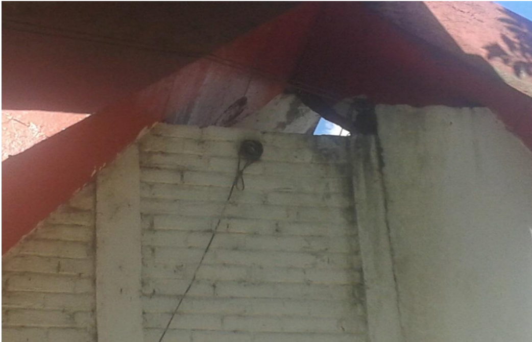
Figura 15. Caja de registro en la parte de la entrada principal a sombra del estadio.
