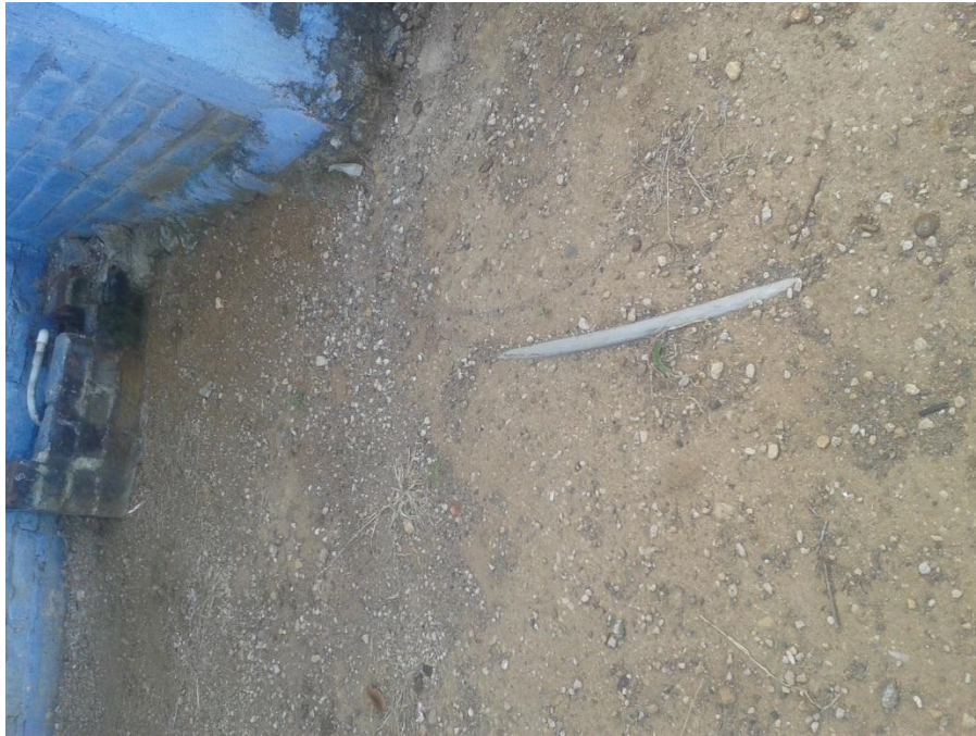
Figura 7. Tubería expuesta.
