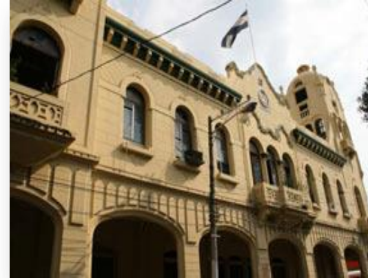
Fotografía.2 FACHADA PRINCIPAL DE LA ALCALDIA MUNICIPAL DE S. M.
