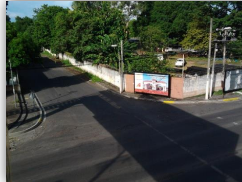
PLANTA DE BOMBEO A.N.D.A.
