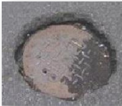
Pozo de Visita de Agua Negra Av. Roosevelt Sur
