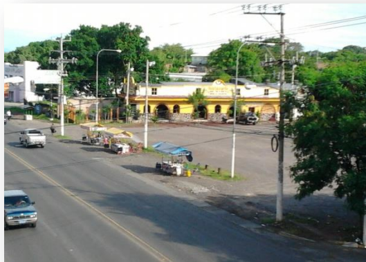
Cables de Alta Tensión Costado norte del Terreno en estudio
