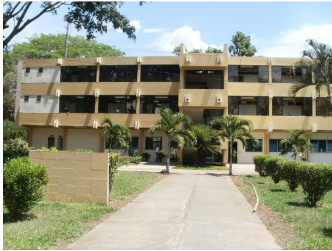
Imagen 1. Edificio Administrativo principal de ENA.
