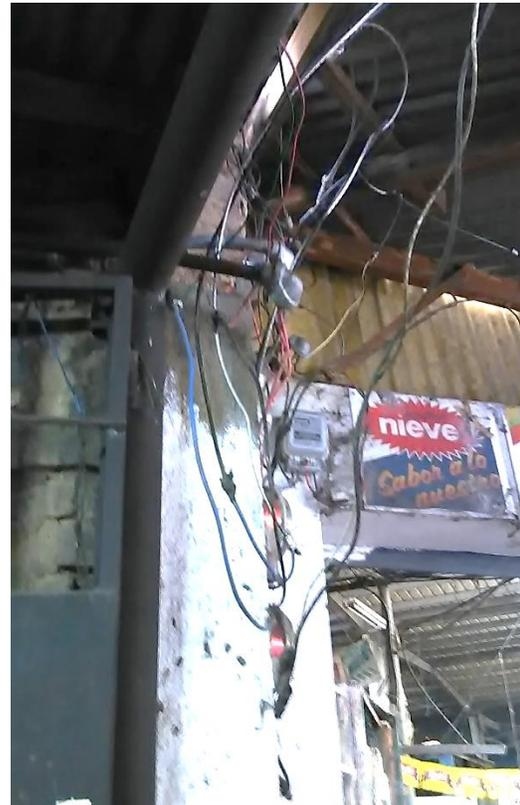
Figura 41 Cables a la intemperie, conexiones desordenadas.
