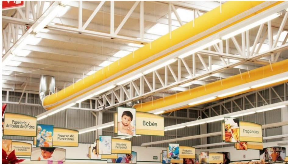
**Ejemplo de sistemas de ducto textil.**
