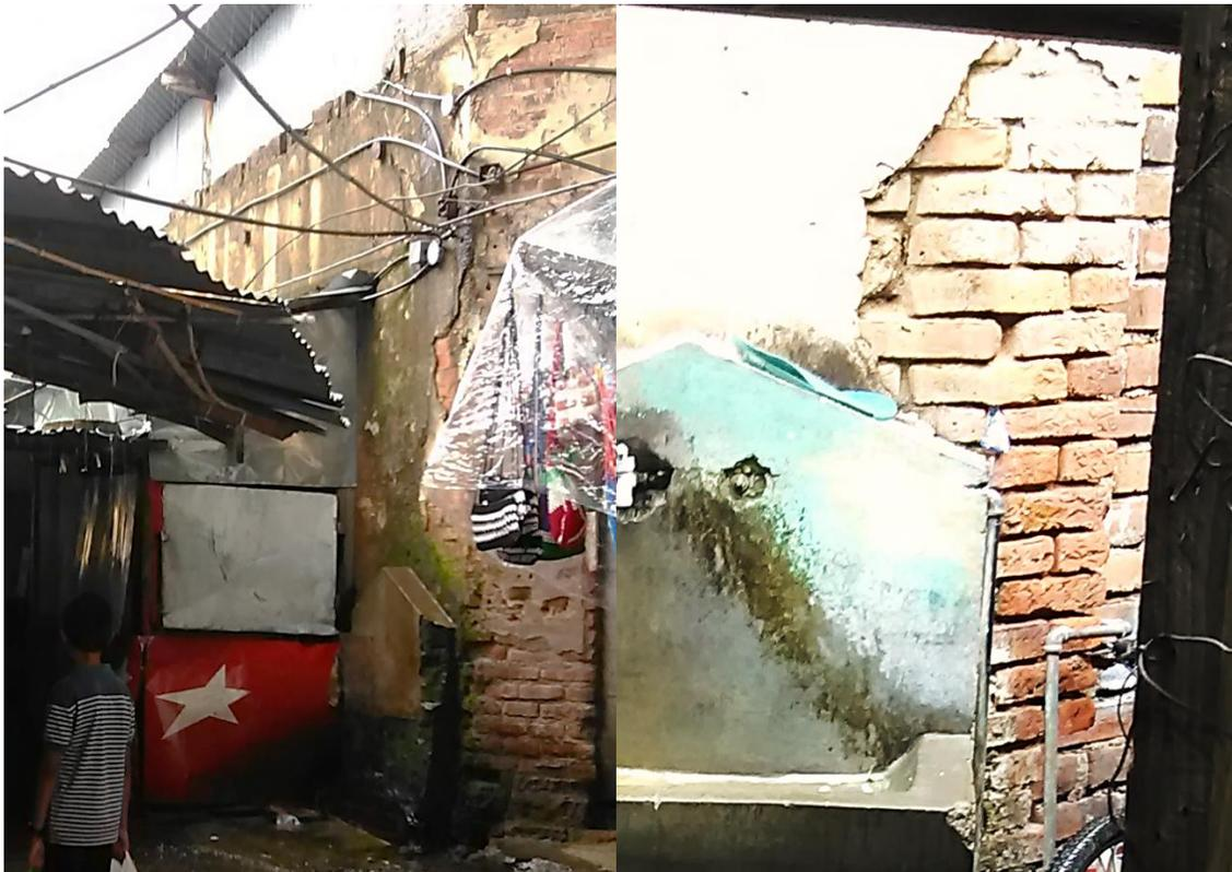
Figura 31 Paredes de ladrillo de barro con grietas, desprendimiento de repello y desconchamiento de pintura.
