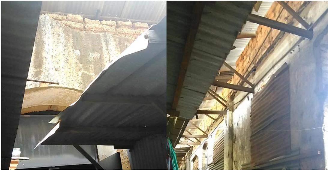
Figura 30 Paredes de adobe con hongo y desprendimientos de repello
