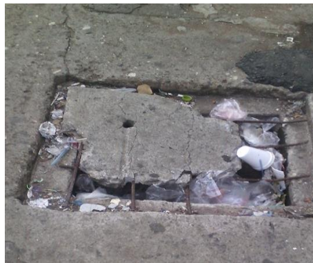
Imagen No. 35 Tubería de entrada A.P. Fuente: Propia
