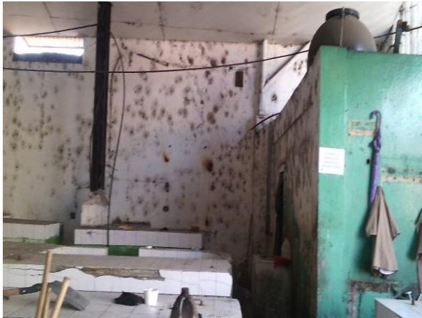
Imagen No. 28 Área de servicios sanitarios Mercado de carnes Fuente: Propia
