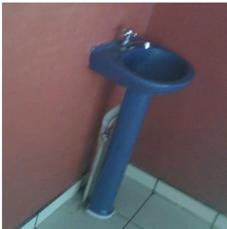
Imagen No. 15 Lavamanos en área de comedor Fuente: Propia
