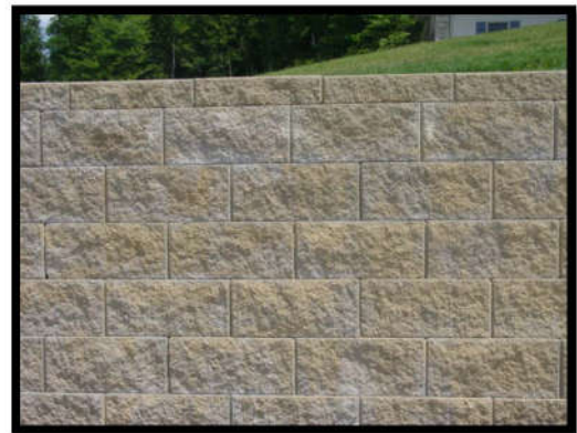
Ilustración 51 Pared de bloques arquitectónicos (split face concrete block).
