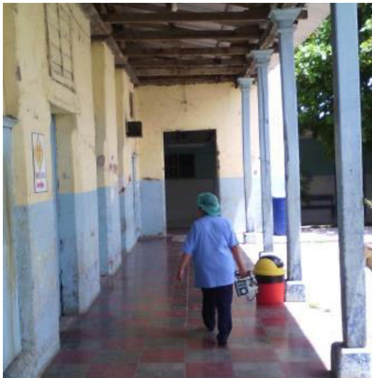
Imagen 66: Pasillo de circulación, Hospital San Juan de Dios
