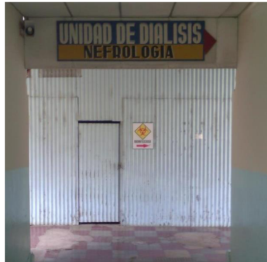
Imagen 65: Pasillo de circulación, Hospital San Juan de Dios
