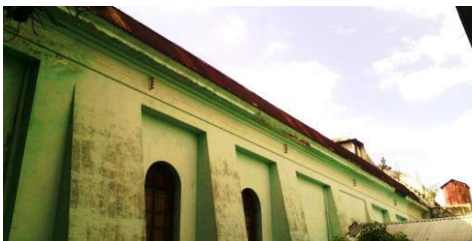
Imagen 24: Contrafuerte costado Oriente
