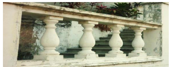
Imagen 25: Balastradas en fachada principal
