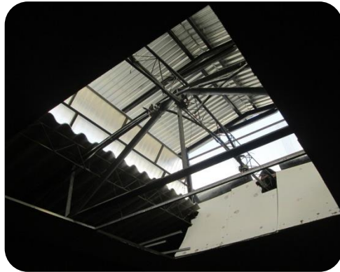
Fotografía de Construcción de tragaluz no finalizada
