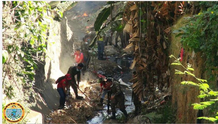
Fotografía No.23. Trabajos de limpieza en Quebrada
