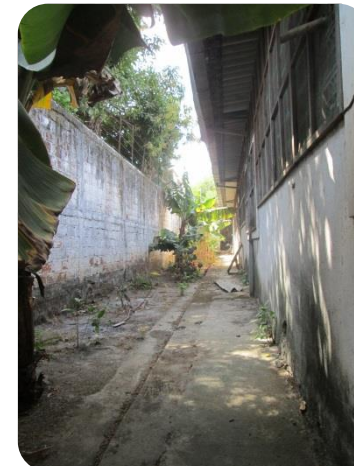
Fotografía de área verde en mal estado
