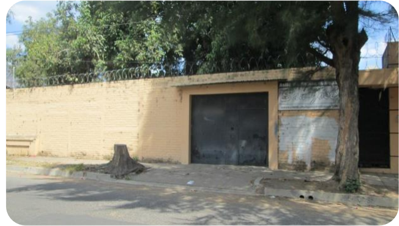
Fotografía fachada de asilo
