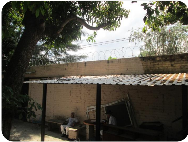
Fotografía de área de visita
