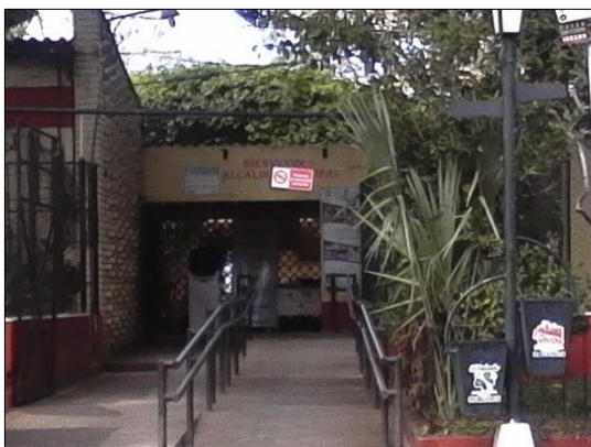
Figura 12. Acceso Ppal. Palacio Municipal
