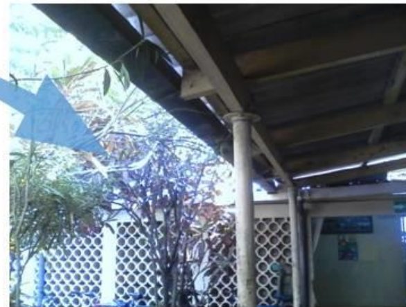
Columnas metálicas colocadas alrededor del patio central.
