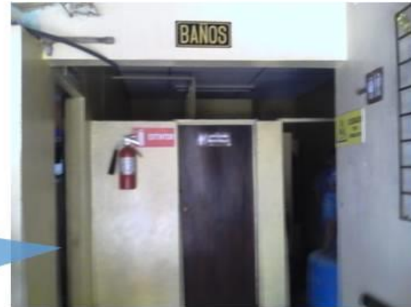
Puerta de Sanitarios de empleadas.
