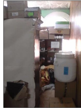
Figura 21. DACI y Almacenamiento de químicos (cloro), documentos y varios.
