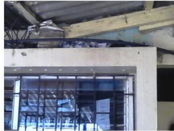
A) Viga ubicada en el departamento de registro familiar.
