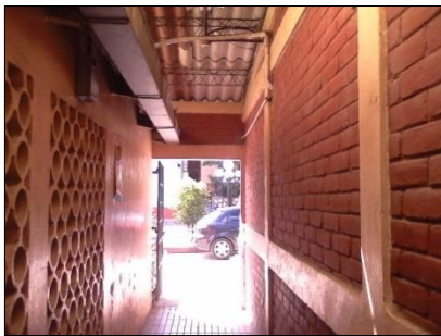
Figura 14. Pasillo que conduce a Parqueo Municipal
