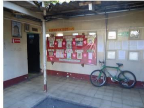
A) Pared de ladrillo de barro. Biblioteca
