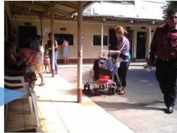
Columnas metálicas colocadas alrededor del patio central.
