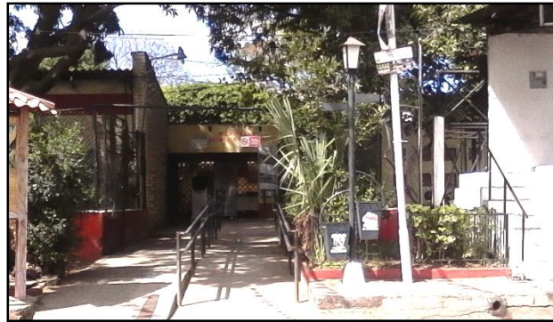
Figura 7. Fachada Principal de Palacio Municipal (12)
