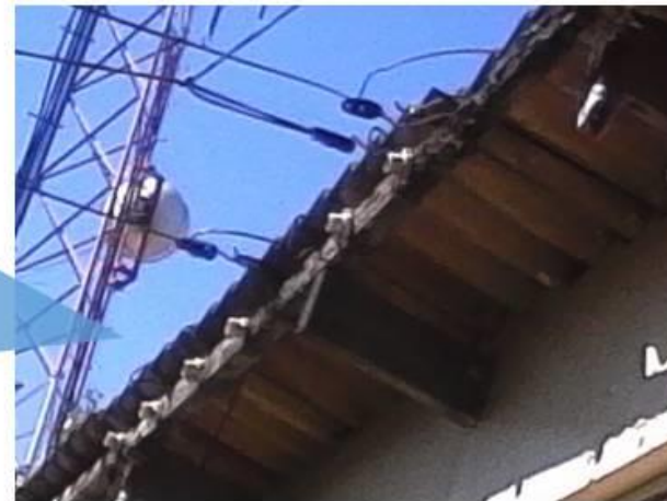
Parte del alero de la fachada principal.
