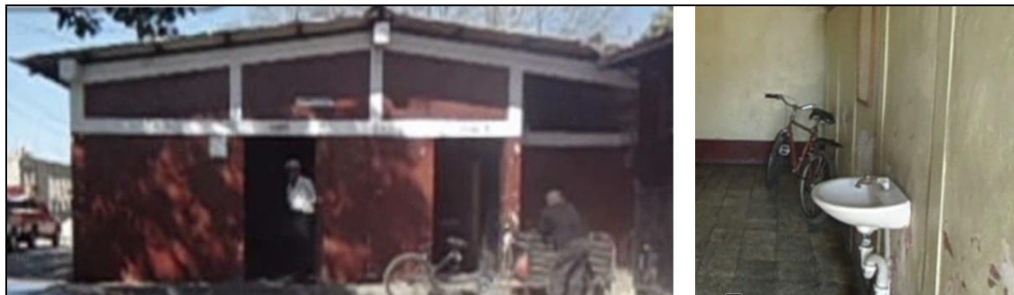
Figura 23. Servicios Sanitarios Públicos.
