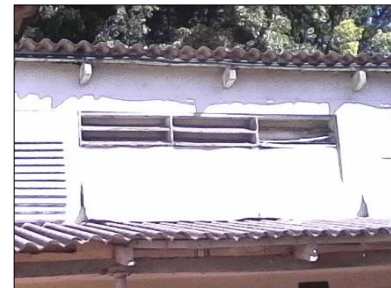
Figura 19. Estado actual de Ventanas de Manera.
