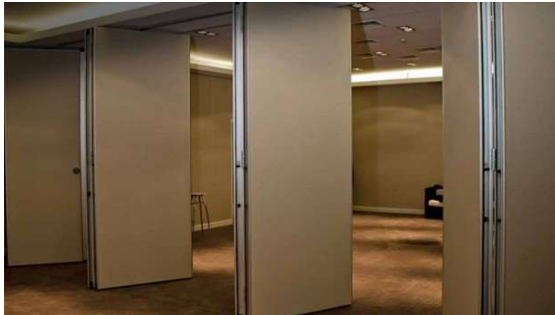
Imagen 67: paredes móviles anti-acústicas.
