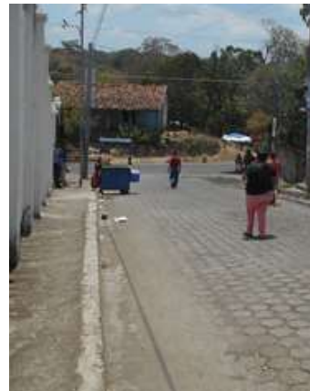
Imagen 47: calle secundaria frente a iglesia
