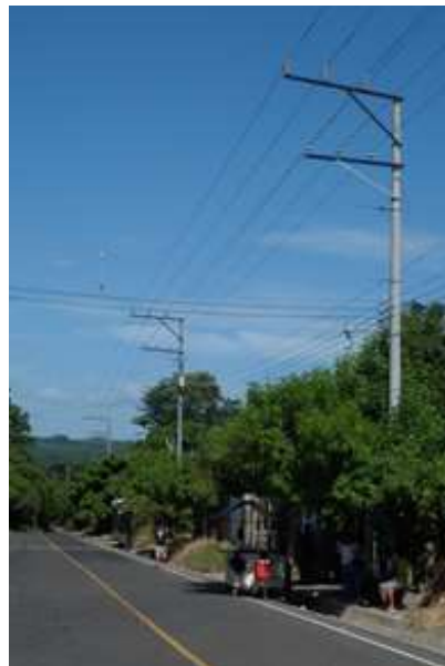
Imagen 63: tendido eléctrico frente a iglesia
