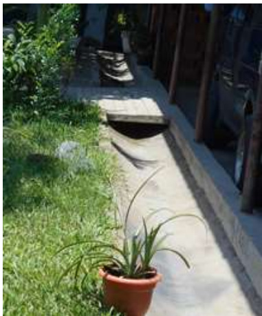
Imagen 61: drenaje de aguas lluvias interna y externa
