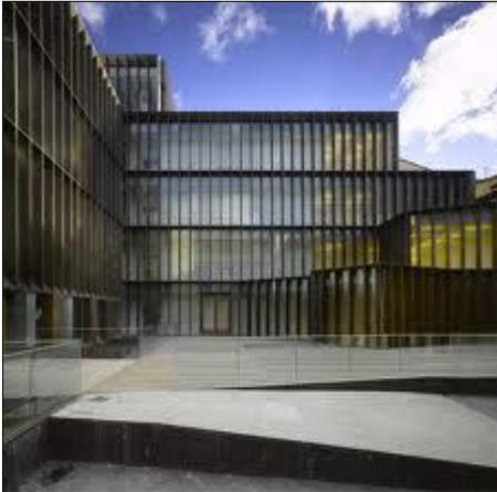
*Ilustración 74 Ritmo sobre fachada de edificación mediante parasoles*
