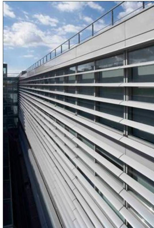
Ilustración 72 Diseño de un Parasol Horizontal
