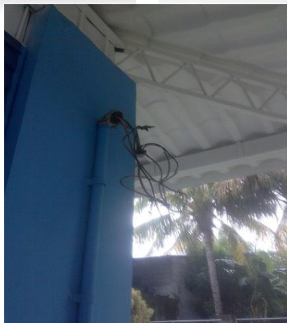
Imagen 36. Instalaciones de Ludoteca
