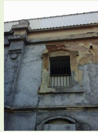
IMAGEN 031 PARED EXPUESTA A CICLOS DE SOL Y AGUA
