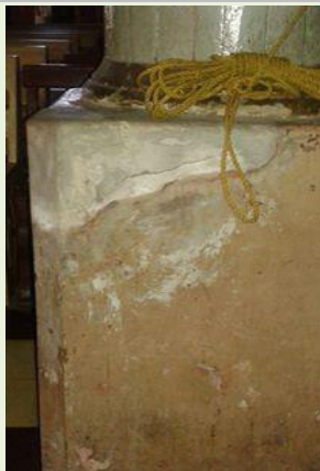
IMAGEN 009 RESANE EN BASE DE COLUMNAS
