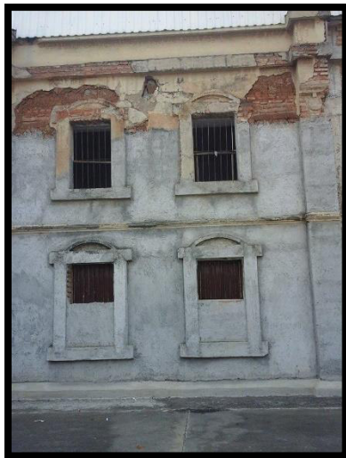
Imagen 23 Exterior de Fachada Lateral Poniente de Convento de San Francisco
