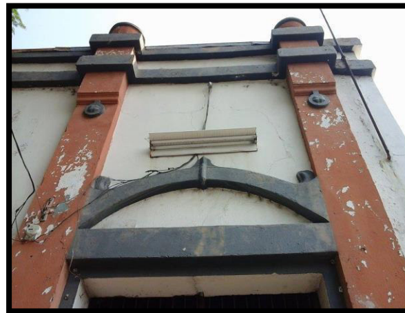
Imagen 24 Parte de la Fachada Principal del Convento de San Francisco
