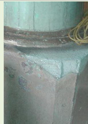
IMAGEN 011 RESANE EN BASE DE COLUMNAS
