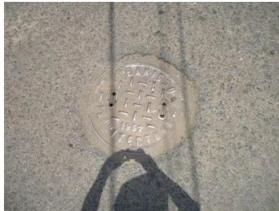
*Imagen 125: Alcantarillado de aguas Lluvias. Referencia: Información Propia.*
