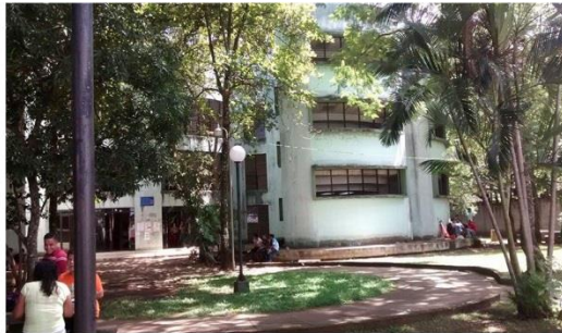
1) Edificio de Aulas Bunker
