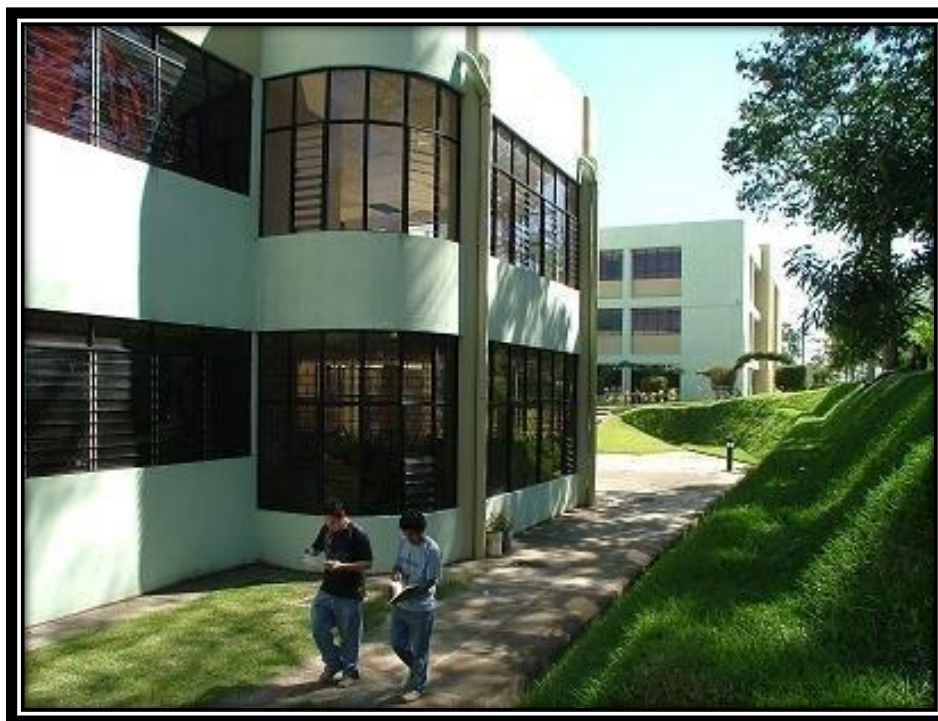
Ilustración 2 Costado sur del Edificio de Ciencias de la Salud dentro de UES FMOCC
