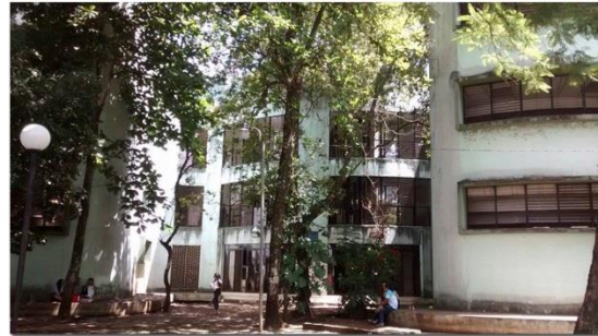
1) Edificio de Aulas Bunker
