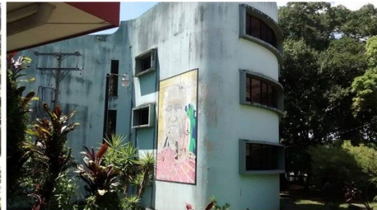
1) Edificio de Aulas Bunker
