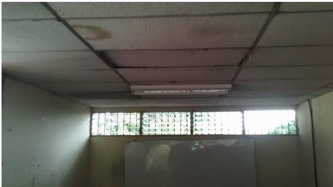
Ilustración 38 Cielo falso del aula Q1 y ventilacion.
