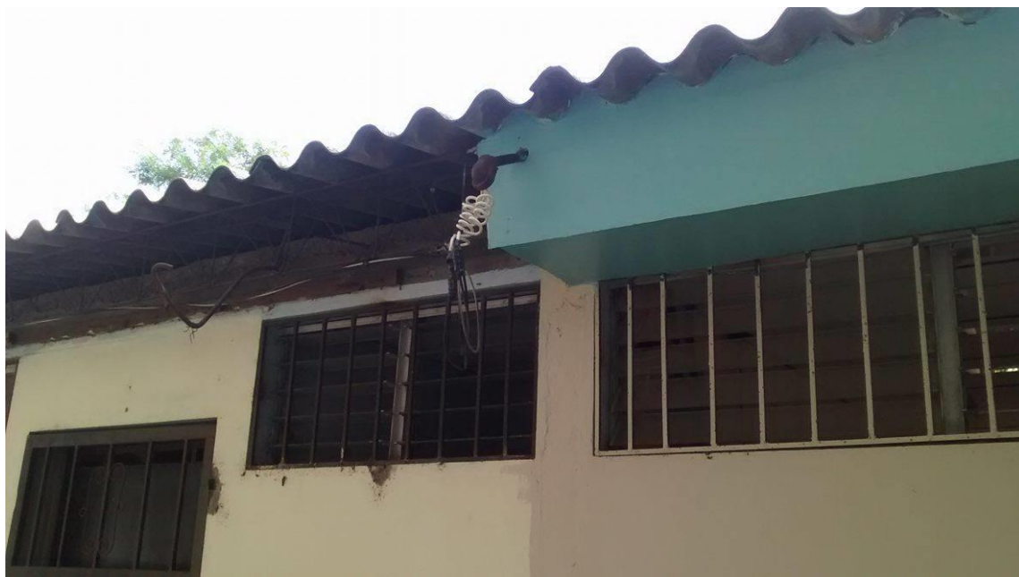
Ilustración 40 Techo de la bodega de química.
