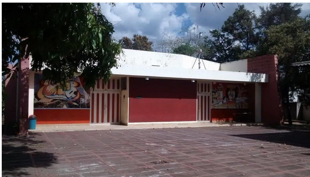
Ilustración 20 Fachada de Auditorio vista desde la Plaza Salvador Allende
