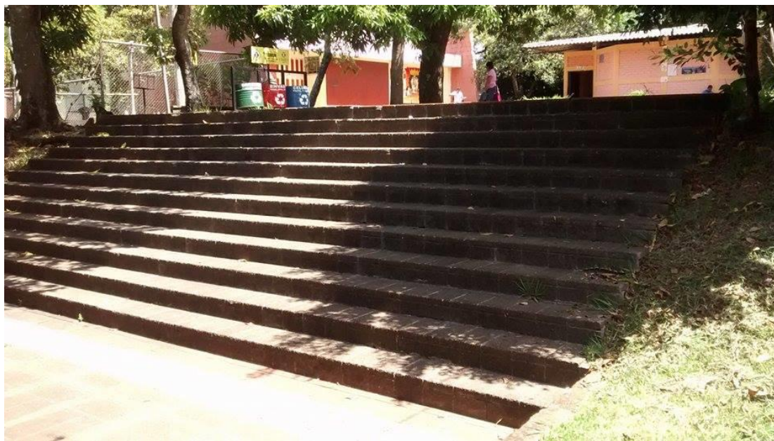
Ilustración 9 Acceso principal a la Zona del Auditorio.
