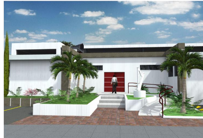
VISTA ESTE, FACHADA PRINCIPAL
