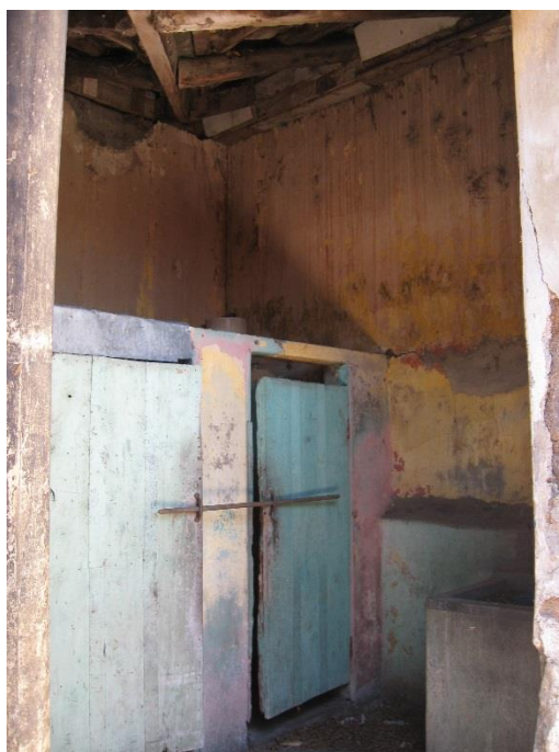
Imagen N°13 Acceso a servicios sanitarios compartidos
