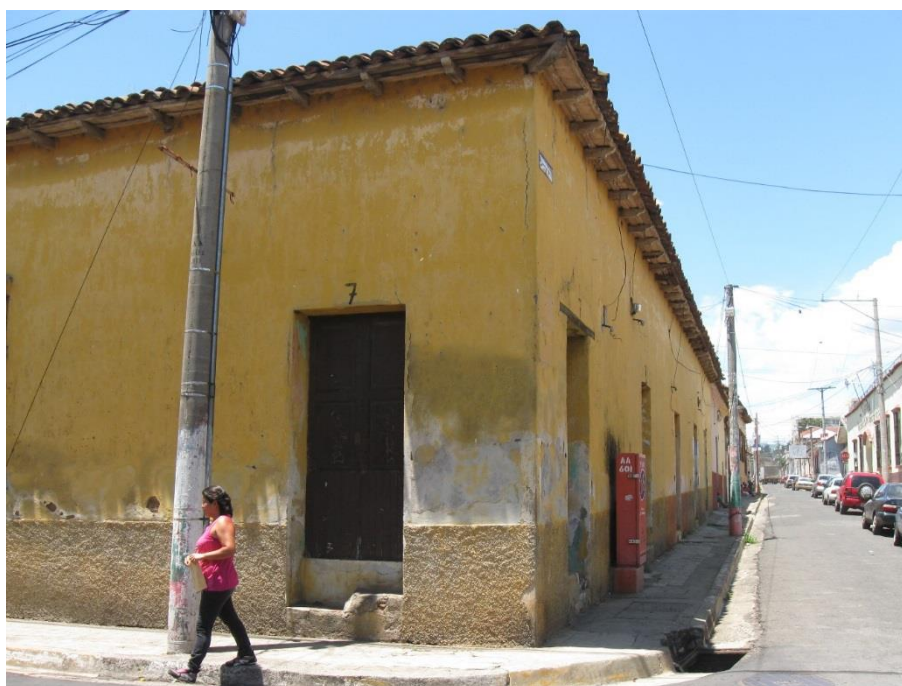
Imagen N°7, Vista Norponiente entre 8ª. Calle Oriente y 5ª. Avenida Norte
