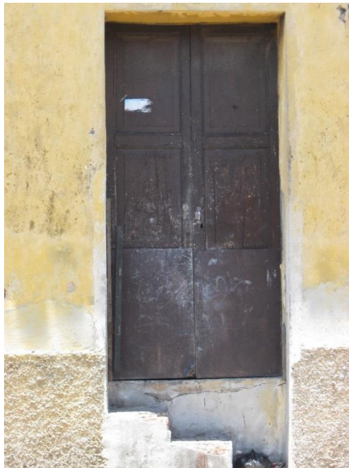
Imagen N°9, Puertas de Acceso externo hacia un apartamento
