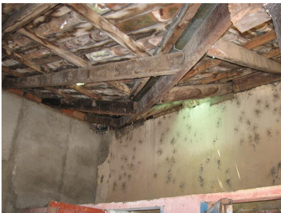
Imagen N°14 Detalle de cubierta de techos en área de servicio
