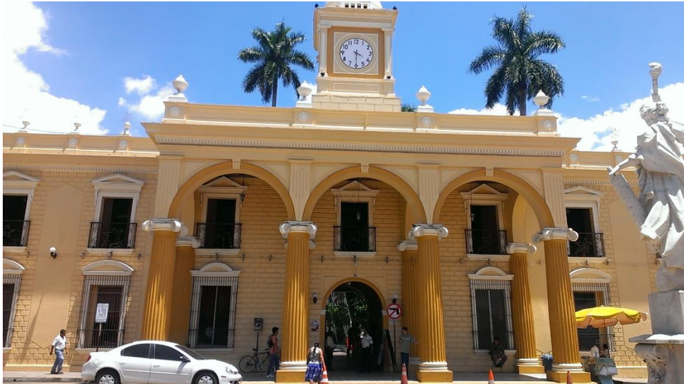
Imagen 19. Fachada principal de la Alcaldía Municipal de Santa Ana.
