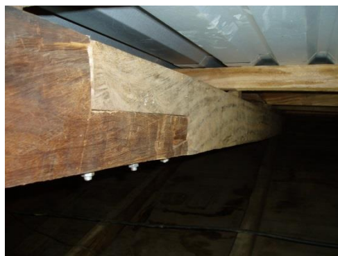
Ejemplo de empalme "a media madera"
