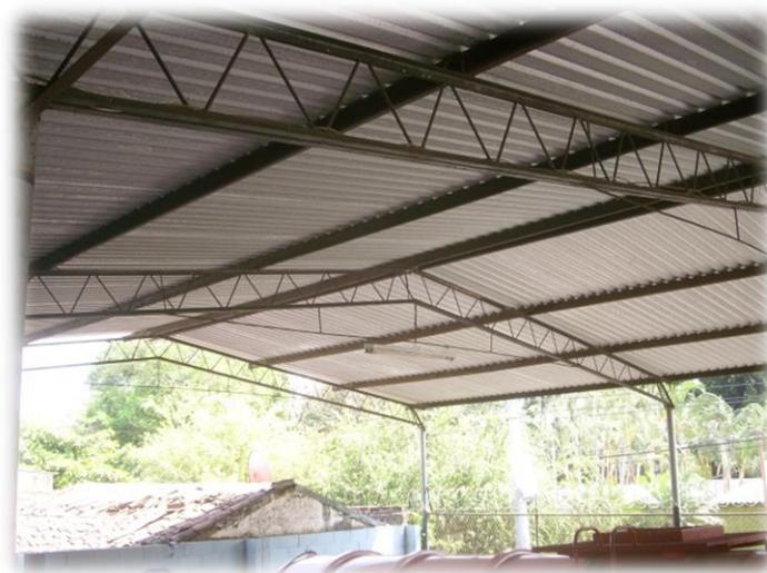
IMAGEN N° 39 CUBIERTA DE LAMINA DE LA PARTE DEL ESTACIONAMIENTO
