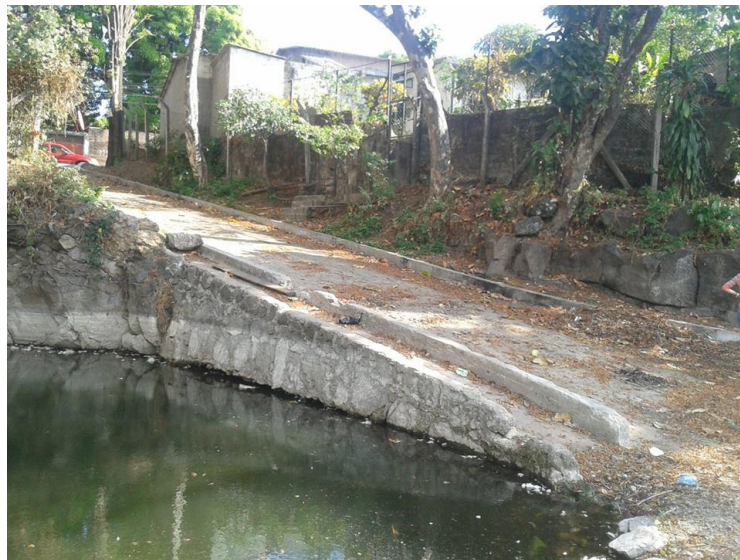
FOTOGRAFIA Nº 3 ACCESO NORTE A LA LAGUNA
