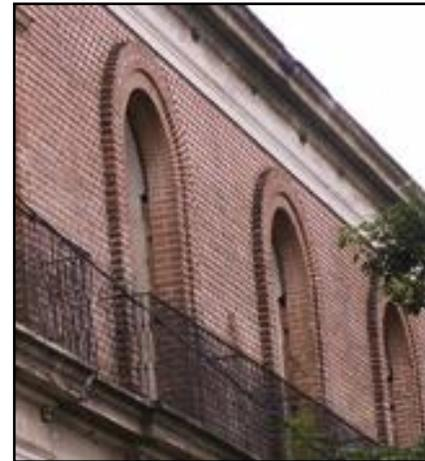
**ARCO PERALTADO O REALZADO.** Tiene su línea de arranque elevada sobre pilares verticales por encima del nivel de las impostas (parte del muro, generalmente formada por una especie de moldura saliente, sobre la que descansa el extremo de un arco)
