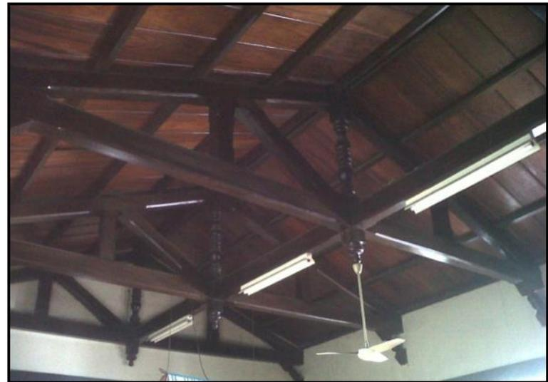
**Imagen 4.23** Tijeras de madera parte de la estructura del techo del Casino santaneco.
