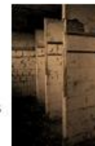
FALTA DE MOBILIARIO EN DUCHAS
