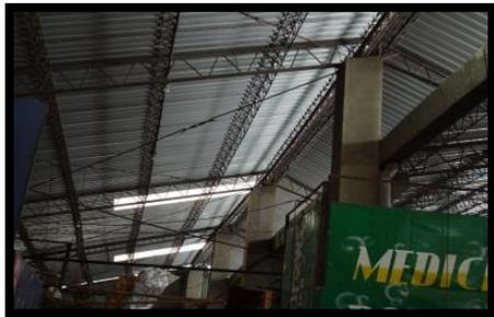
Figura 44. cubierta de lámina canalada
