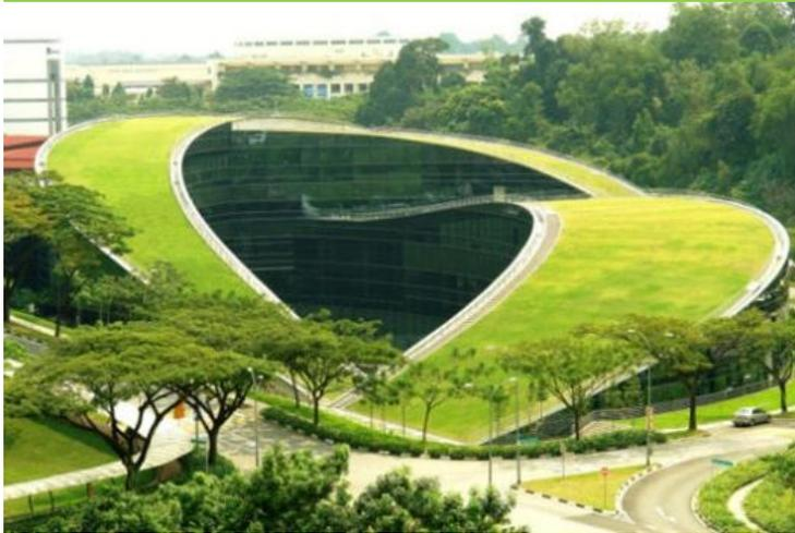
El edificio de 5 pisos ha sido desarrollado por CPG Corporation y está compuesto por dos volúmenes cóncavos hacia el patio interior, cubiertos por una techumbre verde que aísla térmicamente el edificio manteniendo fresco el aire del entorno a la vez que recoge agua de lluvia para el riego de los jardines.<sup>85</sup>
