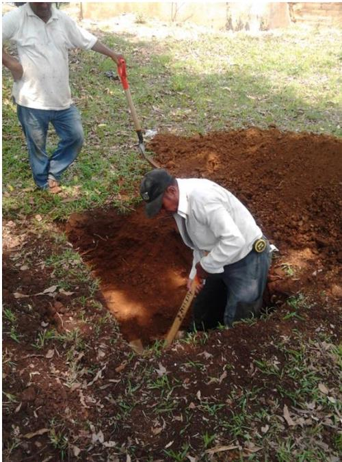
En el lugar se realizó un estudio de tipo exploratorio en el cual se excavaron dos pozos en los puntos que se muestran en el plano para observar los diferentes tipos de suelo y así determinar el dimensionamiento de las estructuras.
