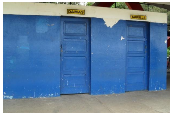
Fotografía 3.2.38: Servicios higiénicos en Sombra (B5 y B6)
