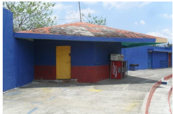
Fotografía 3.2.42: Puesto de venta V1, en Sol General
