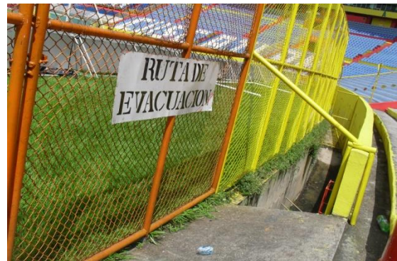
Fotografía 3.3.25: Portón de salida a la cancha y foso de división entre graderíos y cancha en Sol Preferente Norte
