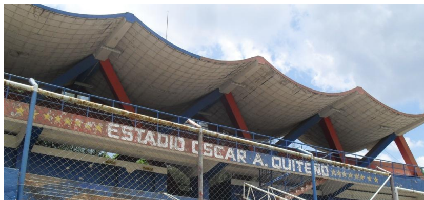
Fotografía 3.2.34: Vista de la cubierta y el sector Tribuna
