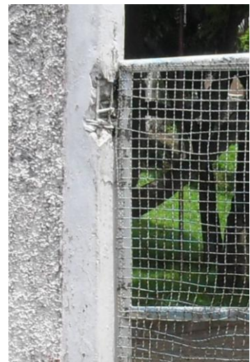
Fotografía 3.4.3: Unión portón-muro en acceso Ax4
