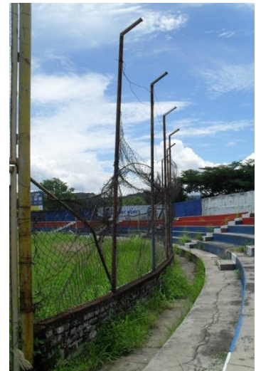
Fotografía 3.4.13: Valla entre gradas y cancha, sector nor-orienté
