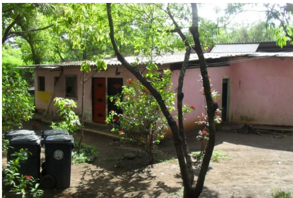
Fotografía 3.2.16: Área de mantenimiento, anexo al Gimnasio municipal
