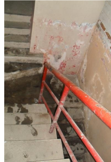
Fotografía 3.2.49: Escaleras de acceso al túnel
