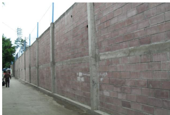
Fotografía 3.3.6: Fachada sur del estadio
