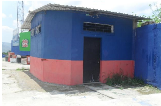
Fotografía 3.2.41: Servicios higiénicos en Sol (B1)
