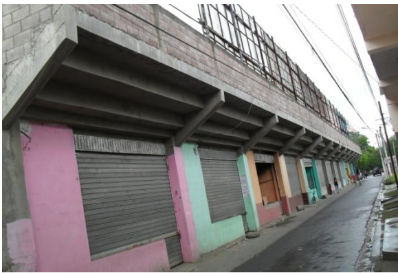
Fotografía 3.3.3: Fachada norte del estadio
