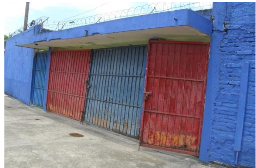
Fotografía 3.2.23: Accesos en Sol General (A1 y A3), en sector sur-oriente del estadio
