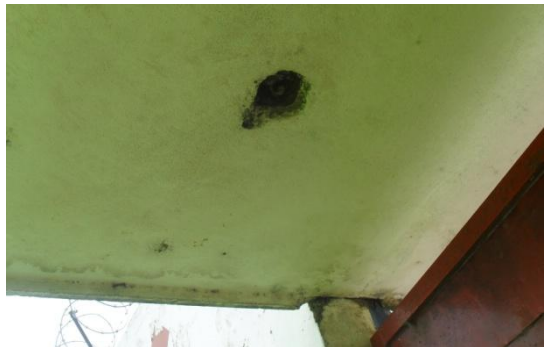
Fotografía 3.4.26: Instalaciones eléctricas en accesos al sureste del estadio
