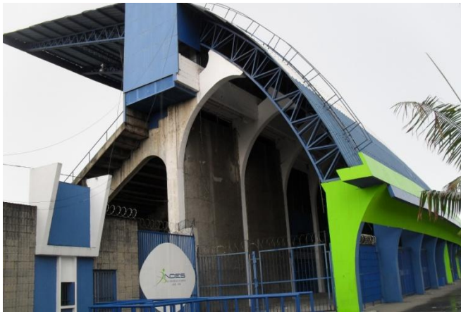
Fotografía 3.3.18: Estructura de los graderíos de Tribuna y de la cubierta
