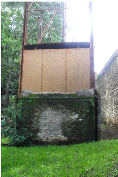
Fotografía 3.2.55: Base de las torres de iluminación del estadio
