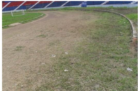
Fotografía 3.4.21: Superficie de pista de atletismo, sector sur-oriente
