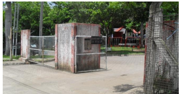
Fotografía 3.2.8: Acceso Ax3, sobre la Av. Fray Felipe de Jesús Moraga Sur
