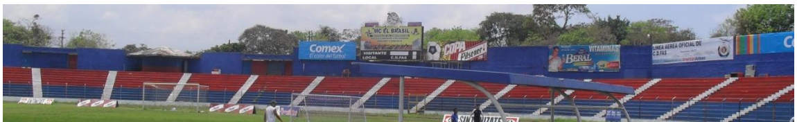
Fotografía 3.2.20: Vista del muro perimetral desde el interior del estadio
