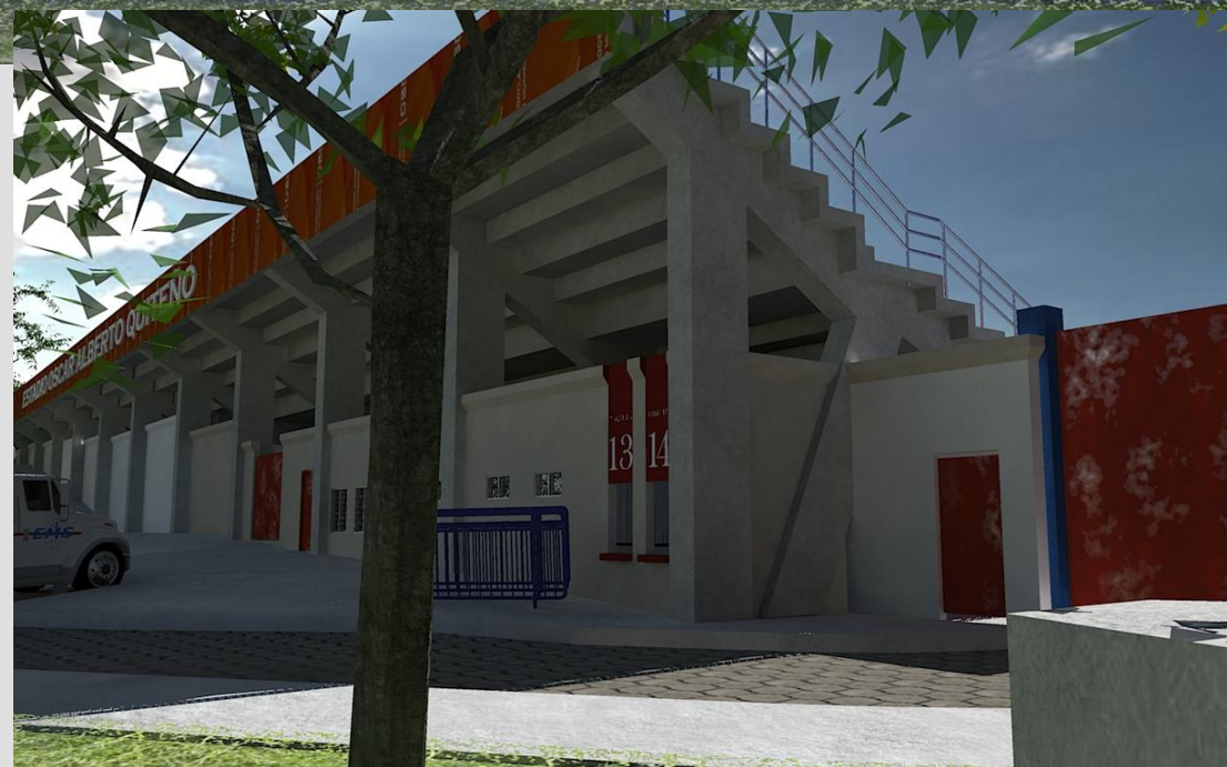
Vistas de la fachada oriente del estadio, donde se ubica un nuevo estacionamiento y la zona de mantenimiento. Arriba: vista desde la 10° Av. Sur, Abajo: vista desde el estacionamiento
