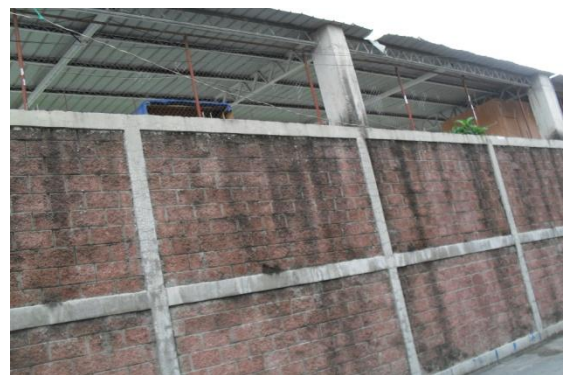
Fotografía 3.3.7: Fachada poniente del estadio
