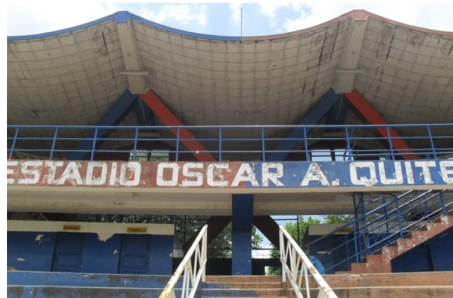
Fotografía 3.2.33: Vista de la estructura desde el interior del estadio
