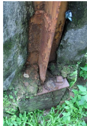
Fotografía 3.4.22: Placa de unión de columnas con cimientos de concreto
