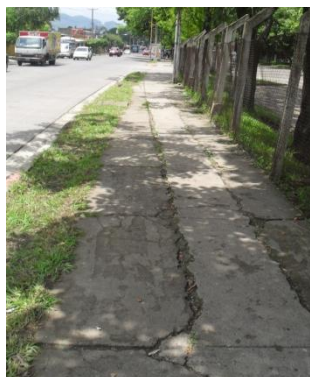
Fotografía 3.2.3: Acera y arriate al poniente del terreno
