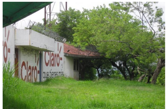
Fotografía 3.2.18: Zona sur-oriente del estadio, externo a Sol General
