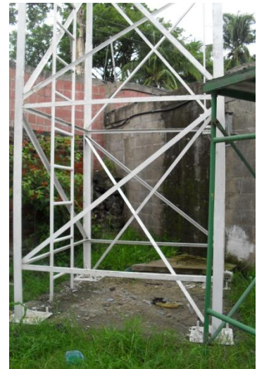
Fotografía 3.3.5: Base de las torres de iluminación del estadio
