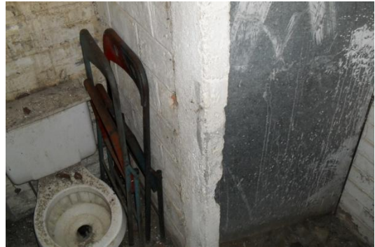
Fotografía 3.4.17: Interior de baños B4, deshabilitado y usado actualmente como bodega
