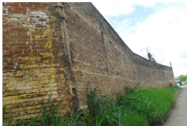
Fotografía 3.2.22: Muro perimetral, vista desde el exterior del estadio
