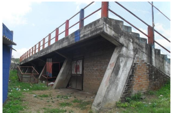
Fotografía 3.2.27: Módulos de graderíos aéreos en Sol General, sector nor-orienté
