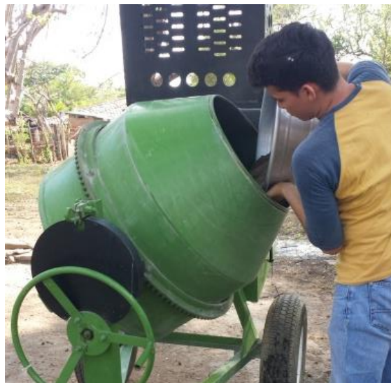
Figura 4-10 Vertido de los materiales a la concretera
