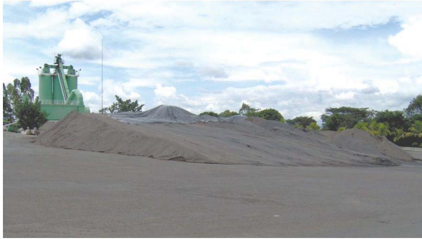
Figura 3.2 Acopio de materiales petreos.
