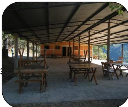
En esta imagen podemos observar, el área de recepciones. Es un área amplia de 420m<sup>2</sup>, contiene una vista llamativa y placentera, sus materiales estructurales están en malas condiciones, su piso es de ladrillo artesanal de barro.
