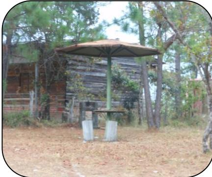
La mesa de picnic o glorieta está construida de madera y sus asientos de troncos, la estructura del techo es de lámina color alum. Parte del mobiliario existente, se conserva en buen estado.
