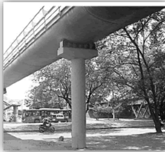
Figura 13: Pila de apoyo en forma de "T".
