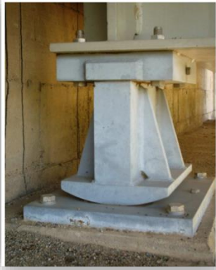
Figura 15: Apoyo de silleta basculante.
