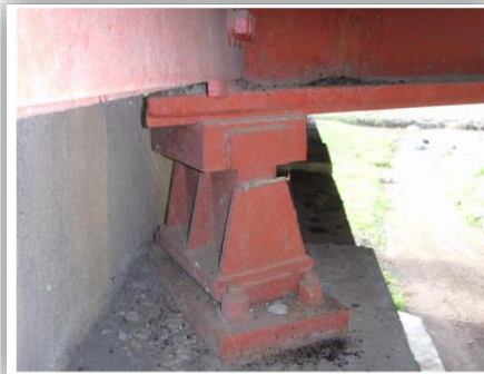
Figura 14: Apoyo Anclado.
