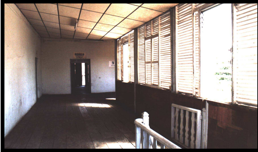
VISTA INTERIOR DEL PASILLO DEL SEGUNDO NIVEL PAREDES DE BAHAREQUE Y MADERA, CIELO FALSO DE FIBROCEMENTO Y PISO ENTABLERADO
