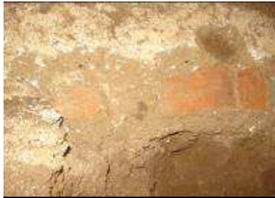
Foto 28: Ladrillo de barro usado como muro de fundación
