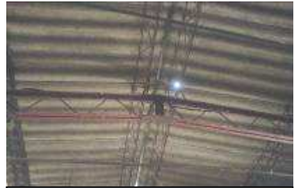
Foto 17: Techo reparado con estructura de hierro y cubierta de asbesto cemento.
