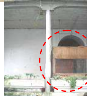
Foto 15: División de costanera y plywwod
