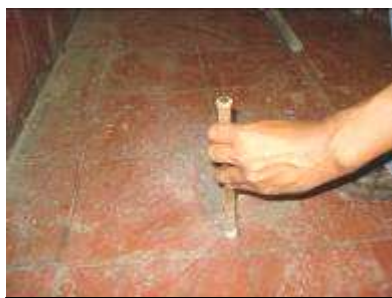
Foto 25: Diagnóstico destructivo, revisando cimentaciones
