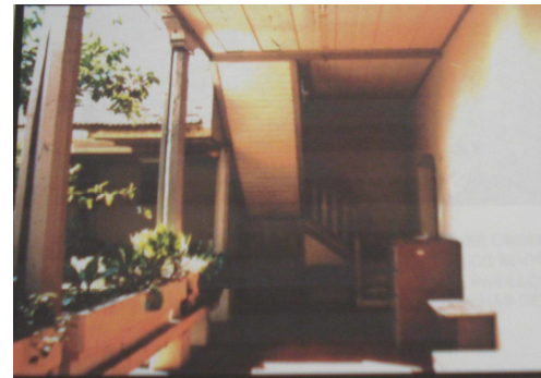
Vista parcial de corredor interior del primer nivel, columnas de madera de sección ortogonal, cielo falso de duelas de madera, al fondo el escalerón que conduce al segundo nivel
