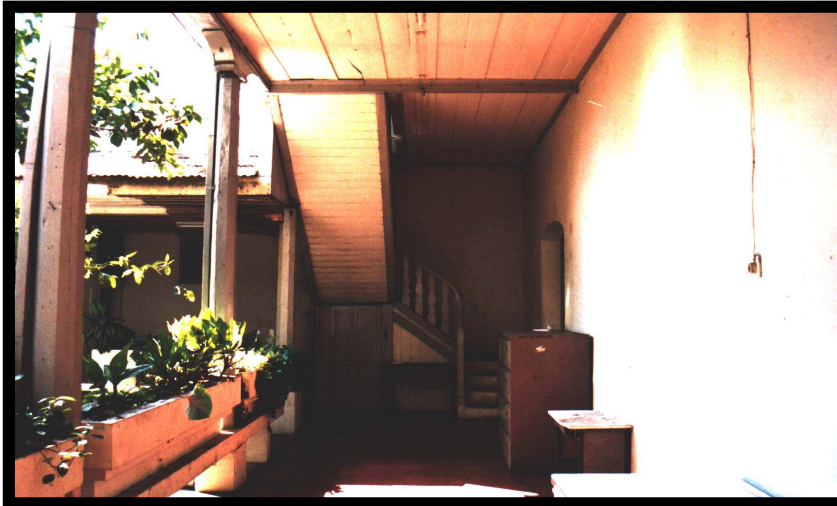
VISTA PARCIAL DE CORREDOR INTERIOR, ENMARCADO POR COLUMNAS DE MADERA DE SECCION OCTOGONAL, CIELO FALSO DE MADERA ENTABLERADA AL FONSO SE OBSERVA EL ESCALERON ELABORADO TOTALMENTE EN MADERA
