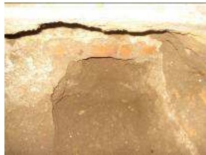
compactación de tierra de fundación.
