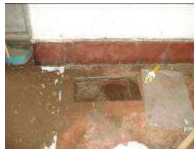
Foto 26: Excavación sobre piso primer nivel
