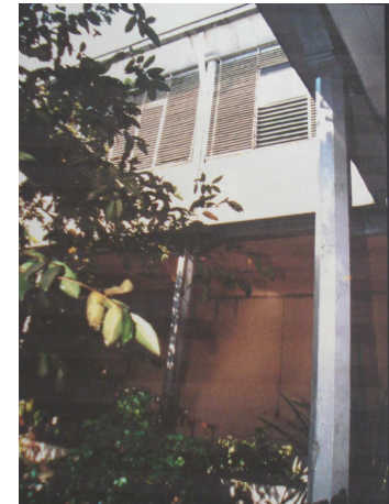
Vista parcial del patio interior del edificio, se aprecia el corredor enmarcado por columnas de madera de sección octogonal que soportan el pasillo del segundo nivel
