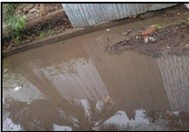
Figura 9: Acumulación de aguas
