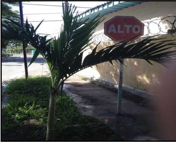
Figura 17: Señalización obstruida por vegetación.
