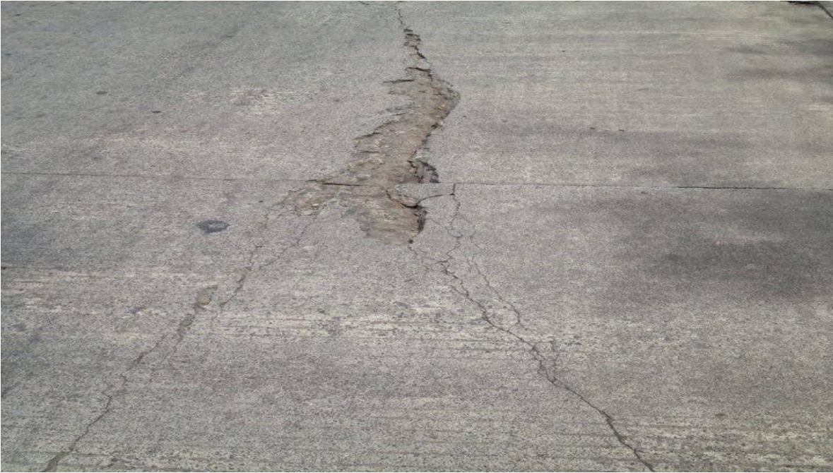
Daño 22: Grieta de borde y daño en la junta
