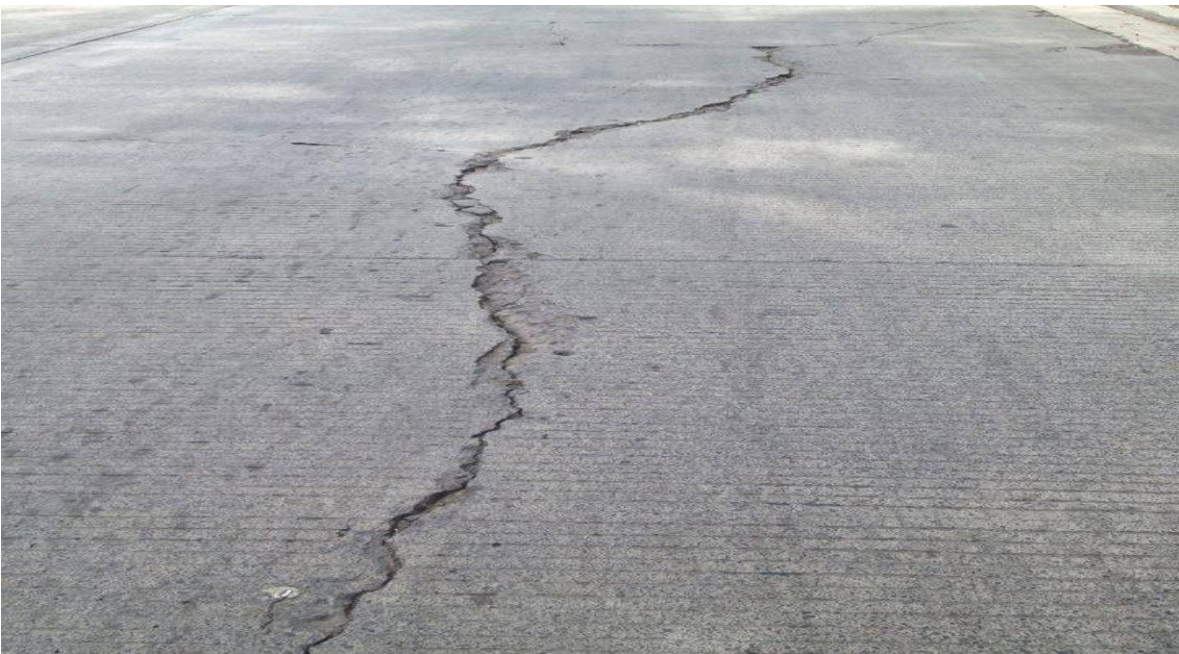
Daño 22: Grieta de borde y daño en la junta
