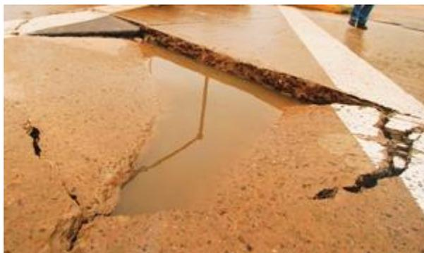
**Figura 2.7** Baches en pavimento rígido
