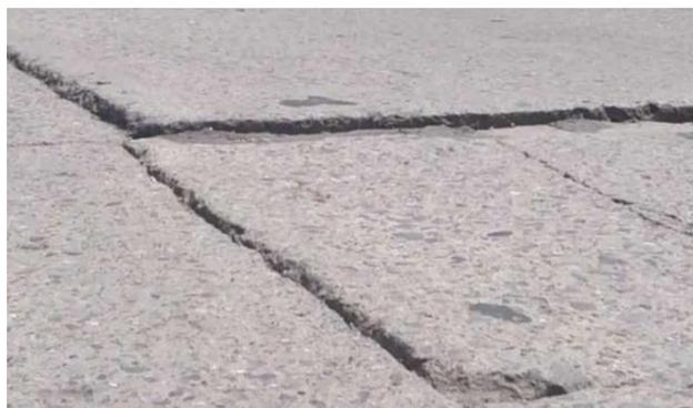
**Figura 2.6** Escalonamiento en juntas de losas
