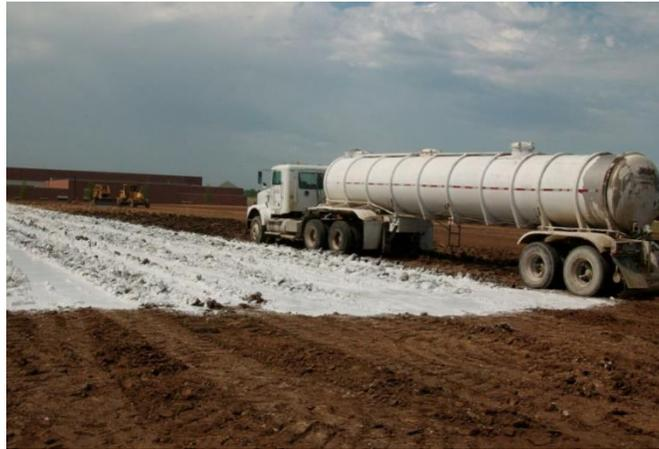
**Figura 2.18** Estabilización de suelos con
