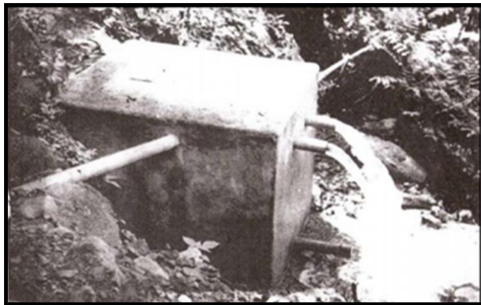
Figura 1.1. Primera caja receptora de agua potable en el municipio de Chapeltique. (1951)
