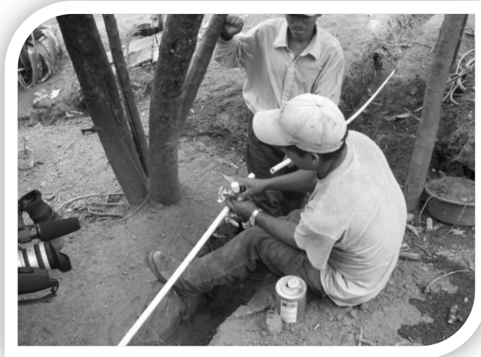
Figura 5.31. Inspección en la línea de distribución
