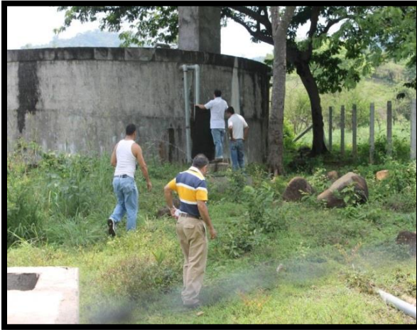
Figura 2.1. Tanque de almacenamiento
