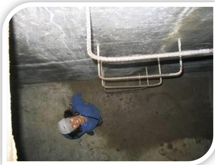
Figura 5.28. Limpieza del tanque de almacenamiento.
