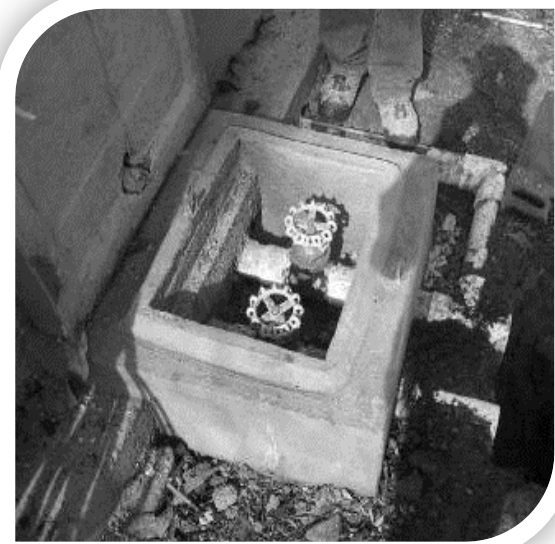
Figura 5.26. Inspección y funcionamiento de válvulas y tuberías
