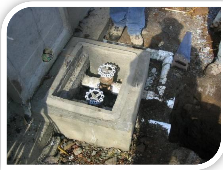
Figura 5.21. Protección de válvulas
