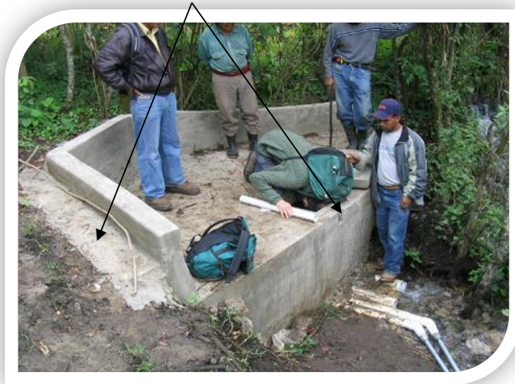
Figura 5.16. Inspección y reparación
