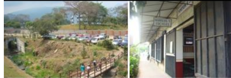
Accesos y señalización del mercado
