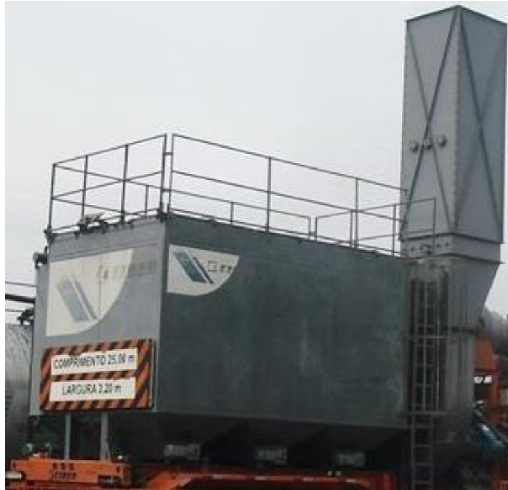
Figura 3.15. Contenedor con los filtros de manga y chimenea Fuente: Registro propio.
