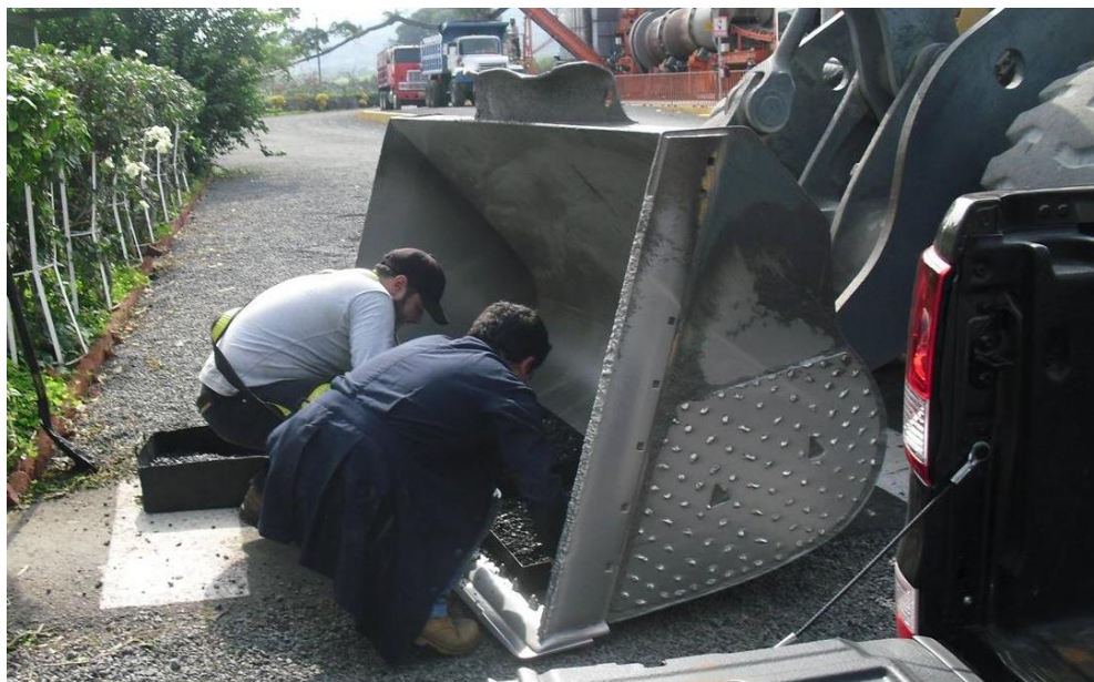
Figura 3.19. Desalajo de bandejas con material en la pala mecánica.
