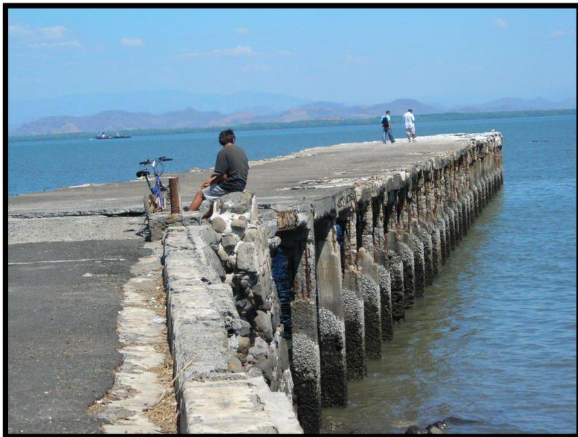
Fotografía 7: Deterioro en el concreto y corrosión del acero en antiguo muelle artesanal, La Unión
