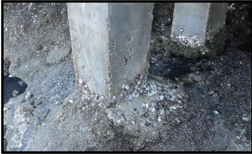
Fotografía 10: Deterioro en columna por contacto con agua de mar y organismos marinos, La Unión
