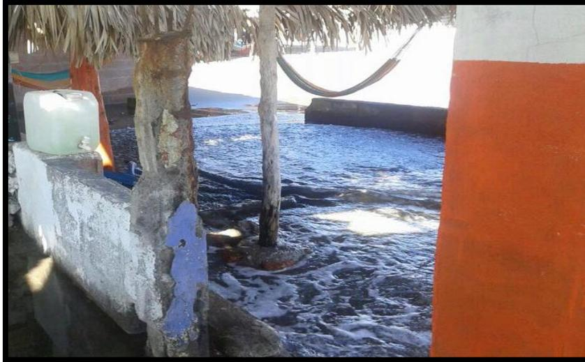
Fotografía 6: Deterioro en el concreto y corrosión por cloruros en playa Las Tunas, La Unión
