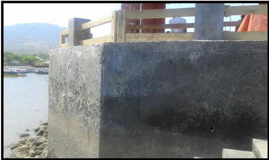
Fotografía 9: Pérdida de la capa superficial del concreto en muelle de la ciudad de La Unión
