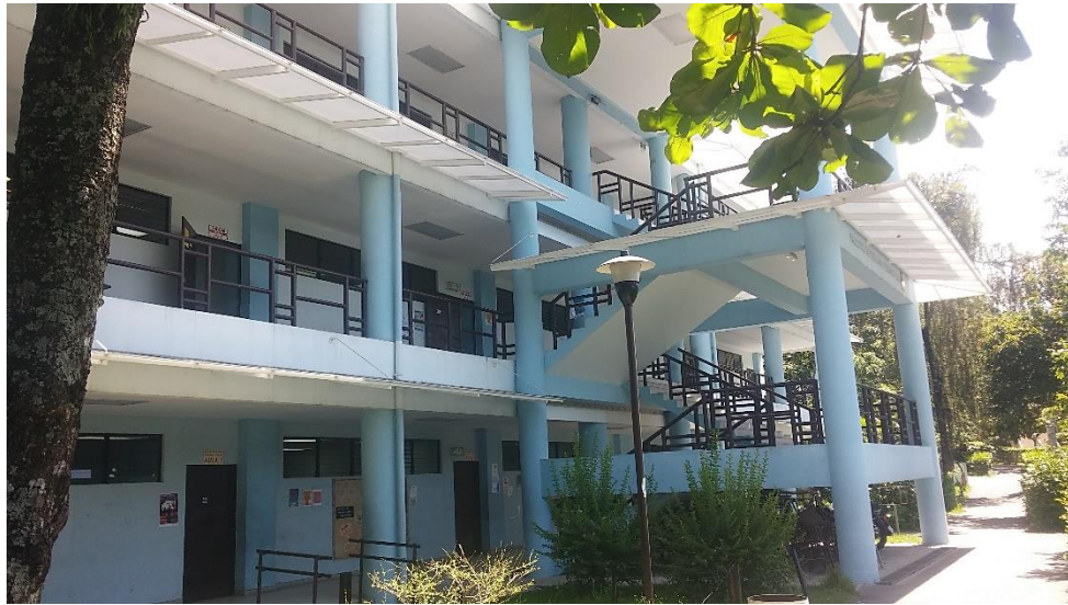
Figura 3.22 Edificio de “Facultad de Ciencias y Humanidades” Vista Lateral
