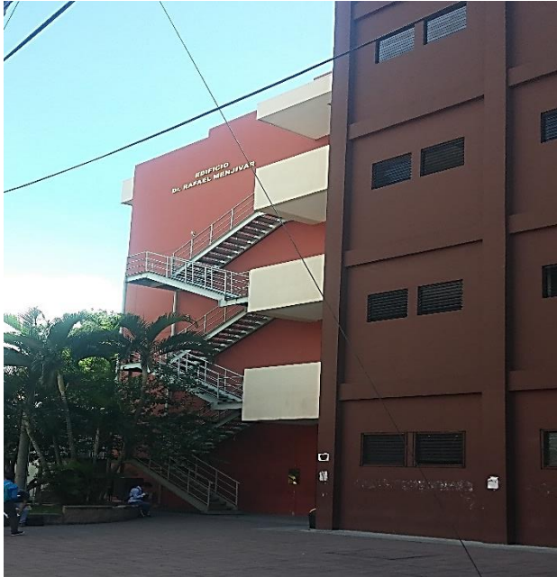
Figura 3.17 Edificio de “Dr. Rafael Menjivar Facultad de Jurisprudencia y Ciencias Económicas”, Vista Frontal.
