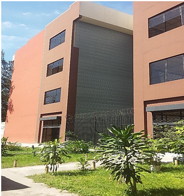
Figura 3.18 Edificio de “Dr. Rafael Menjivar Facultad de Jurisprudencia y Ciencias Económicas”, Vista Posterior.
