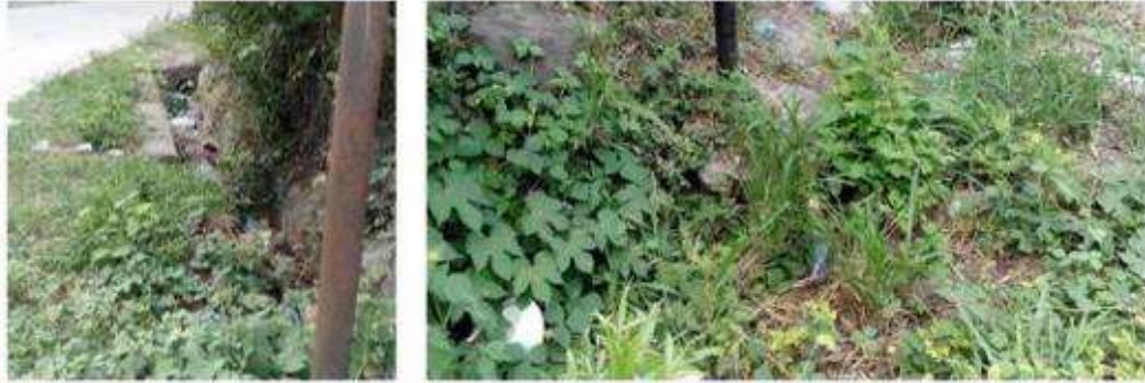
Imagen 3.4. Derramadero de intersección de calle rural MOR24E a conectar en canaleta tipo 2.
