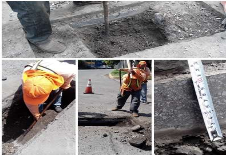
Imagen 5.3. Pozo Cielo Abierto # 4 a un costado del eje de rodaje.
