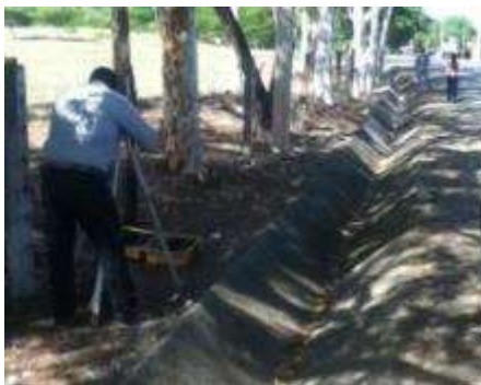
Imagen 3.25 Levantamiento topográfico de la propiedad privada y canaleta.
