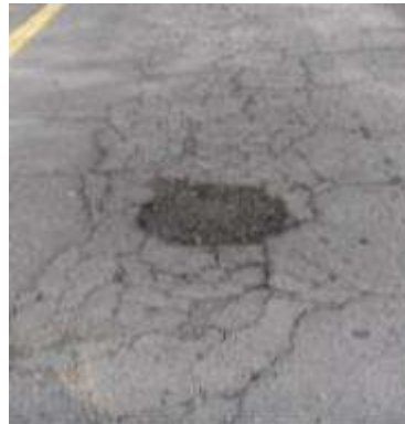
Imagen 3.11. Piel de cocodrilo en intersección DV-RN.
