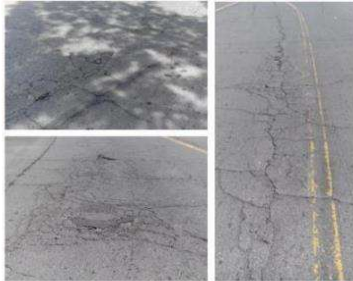
Imagen 3.7 Piel de cocodrilo en intersección de CAM-DV.
