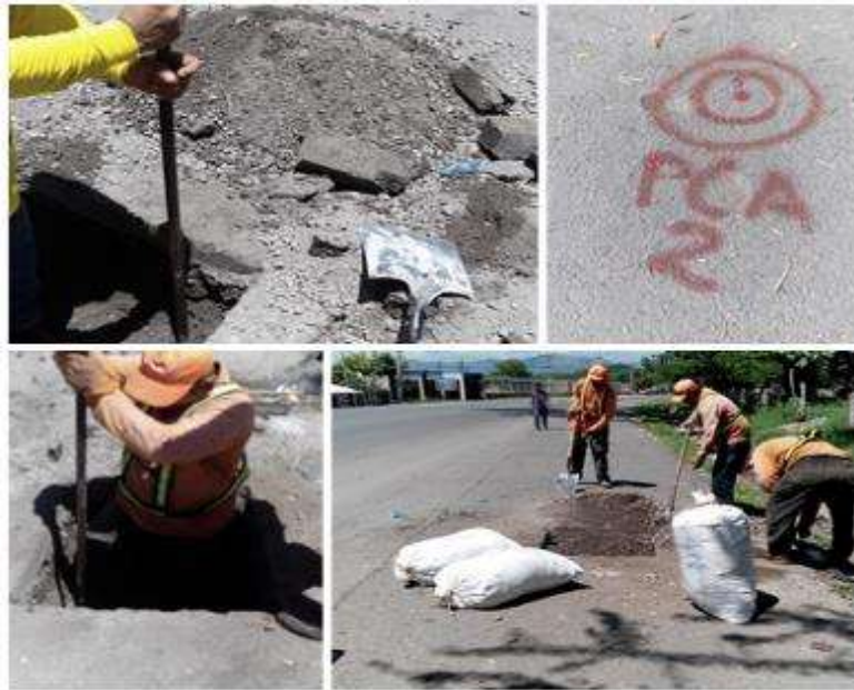
Imagen 5.1. Pozo Cielo Abierto # 2 en hombre de la carretera RN18.
