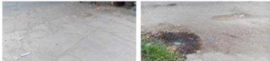
Imagen 3.5. Badén en intersección a calle rural MOR24E.
