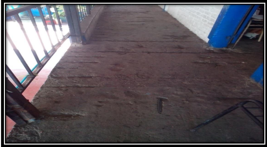
Figura 18. Pasillo de segunda planta
