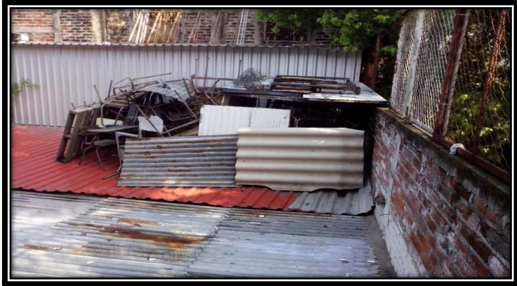
Figura 22. Techo de la institución
