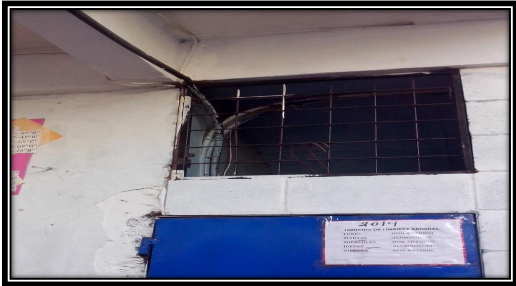
Figura 10. Cuarto de bodega
