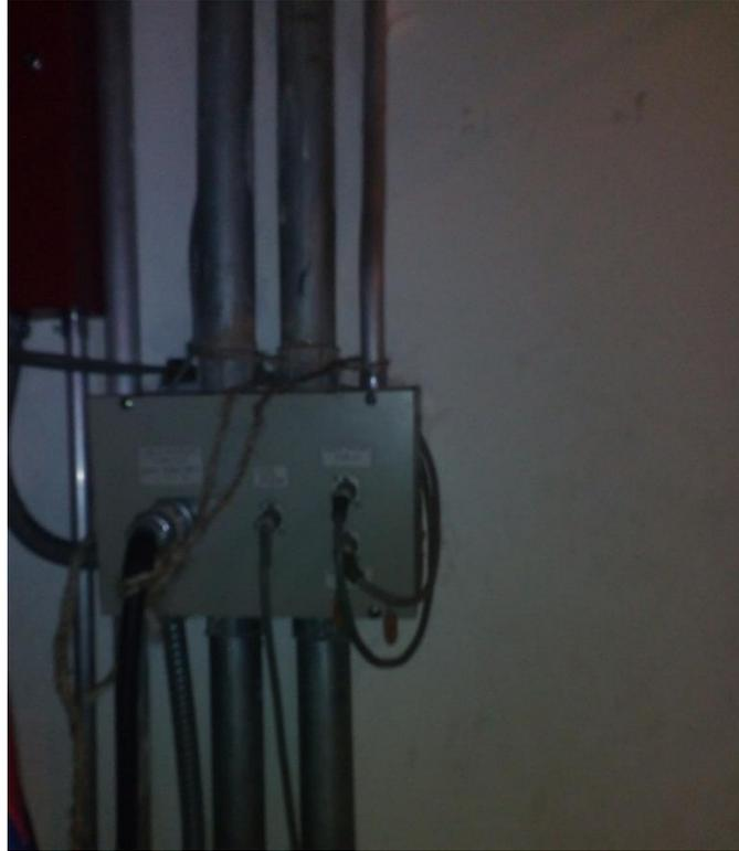
Foto #10 No existen señalización de peligros y prohibición ante riesgo eléctrico.
