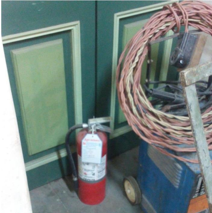
Foto # 8 No se encuentran ubicaciones específicas para extintores ni señales de ubicación.
