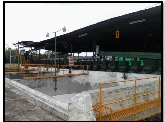
Imagen 7. Pilas de recepción
