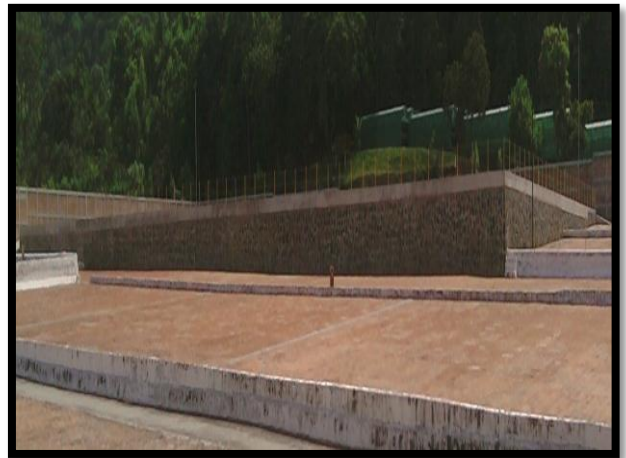
Imagen 36. Planta de tratamiento de agua
