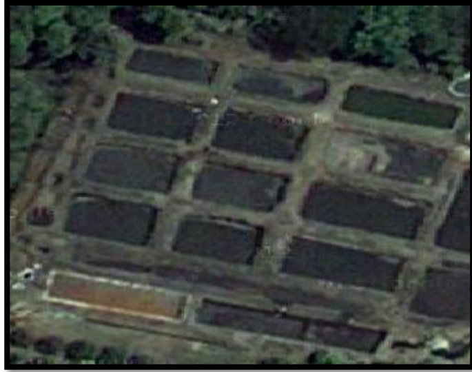
Imagen 22. Vista de las pilas de recepción
