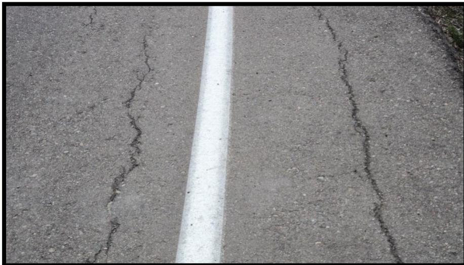
**Figura 2.11** Falla de grietas longitudinales y transversales.
