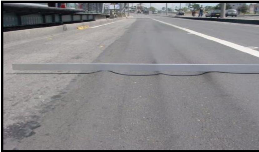
**Figura 2.16** Falla de ahuellamiento
