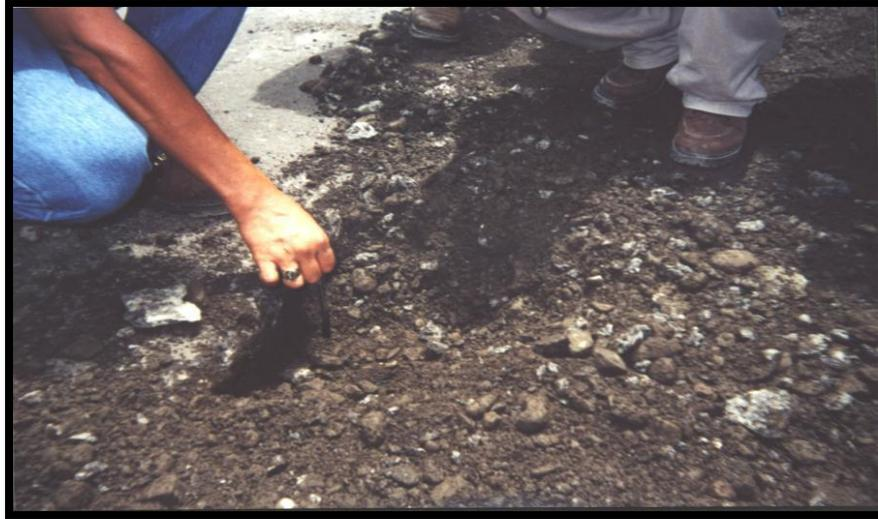
**Figura 5.12** Verificado de espesor de las partículas.
