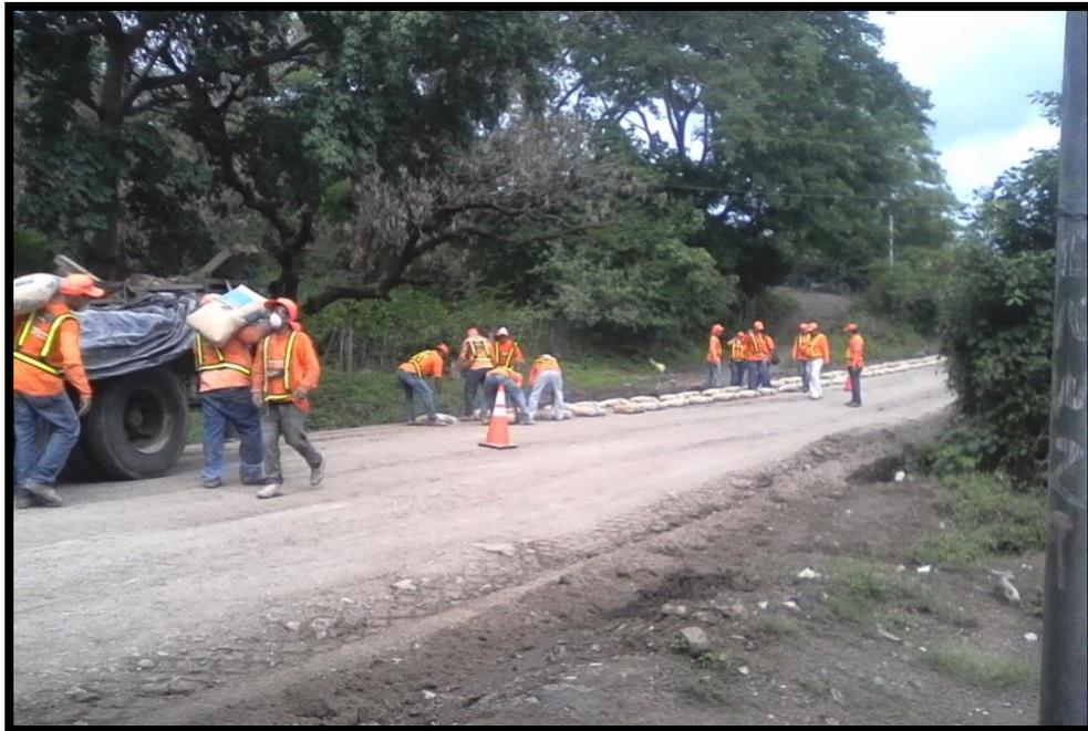
**Figura 5.6** Distribución del agente estabilizante cemento.
