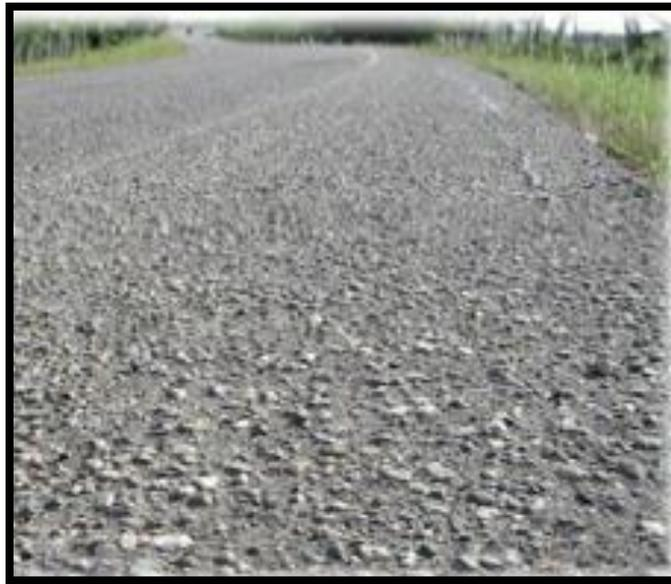
**Figura 2.20** Falla de desprendimiento de agregados
