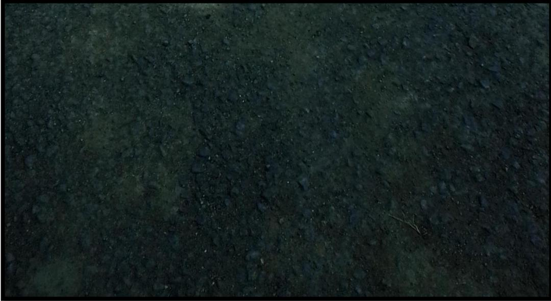
**Figura 2.13** Falla pulimento de agregados.
