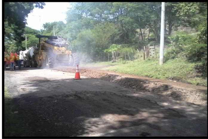
**Figura 5.1** Escarificación del pavimento viejo y base
