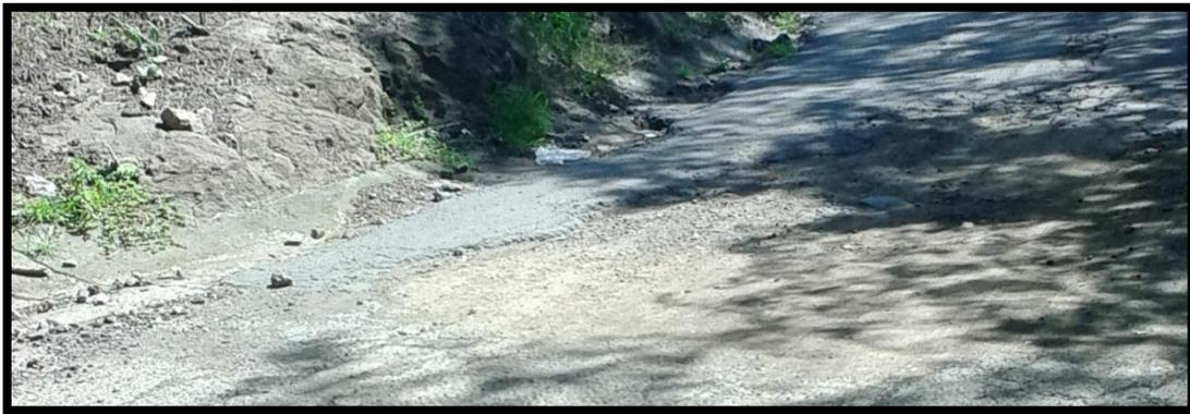
**Figura 2.6** Falla de abultamiento y hundimiento
