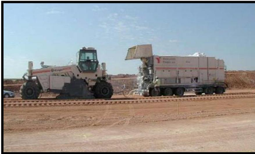
**Figura 2.22** Ejecución de estabilización de explanadas. (Fuente ANCADE)
