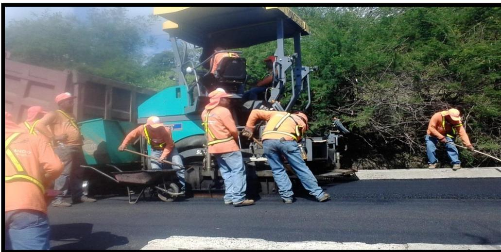
**Figura 5.15** Colocación de la mezcla en el sitio.
