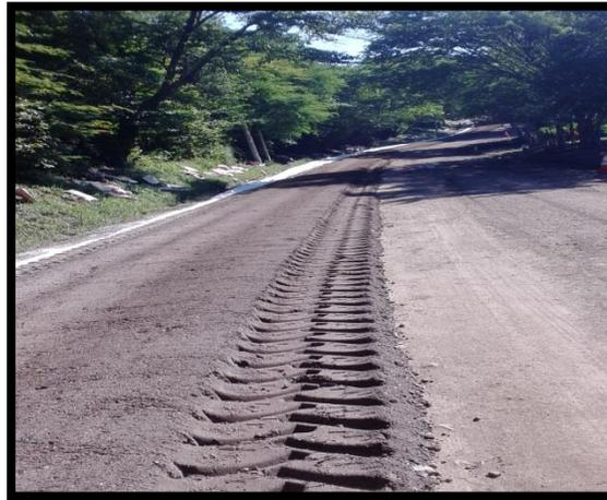
**Figura 5.4** Mezclado de la capa reciclada.
