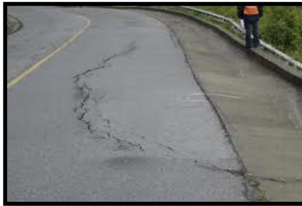
**Figura 2.18** Falla de grietas parabólicas
