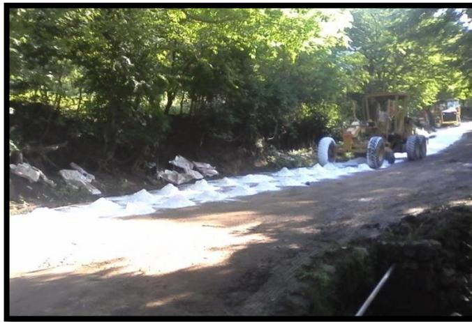
**Figura 5.3** Extendido de la cal con motoniveladora.
