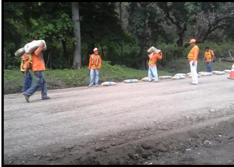
**Figura 5.10** Colocación del cemento para un 3.5%.
