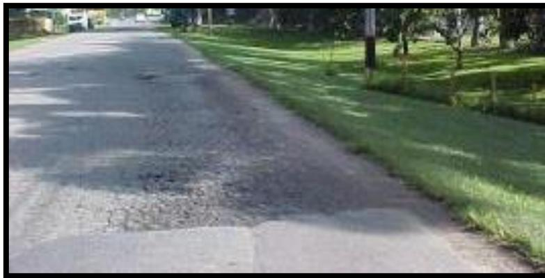
**Figura 2.17** Falla de desplazamiento
