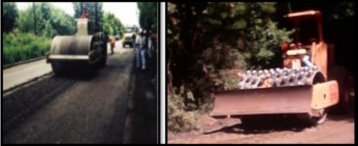
**Figura 5.14** Utilización de compactadores vibratorios.(Fuente Manual WIRTGEN)
