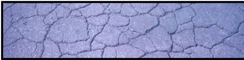
**Figura 2.5** Falla de agrietamiento en bloque
