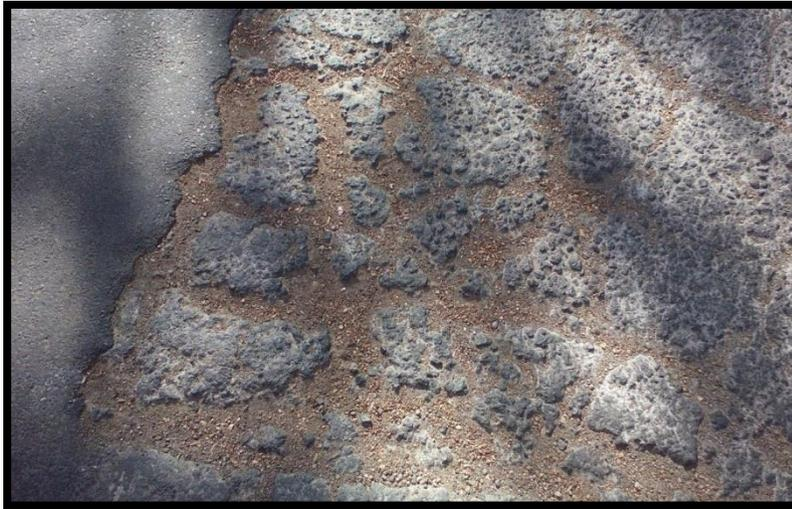
**Figura 3.3** Deterioro del asfalto en carretera en estudio
