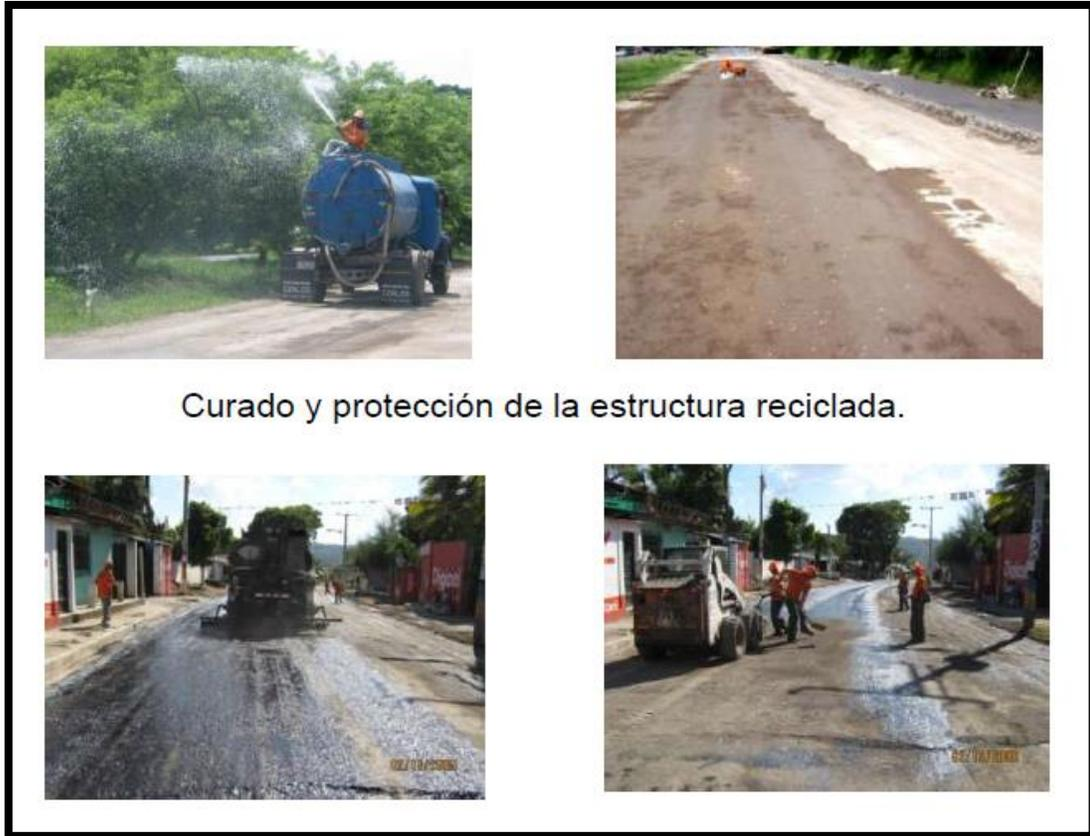
**Figura 3.6** Control de calidad en el proceso constructivo. (Fuente FOVIAL)
